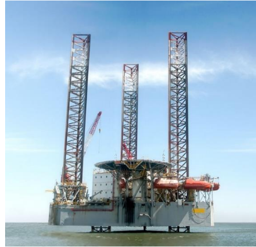
Obr. 13: Konstrukce ropné věže z oceli S690QL [21]
