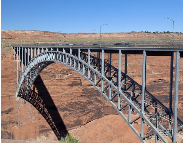
Obr. 12: Konstrukce mostu z oceli S690QL [21]
