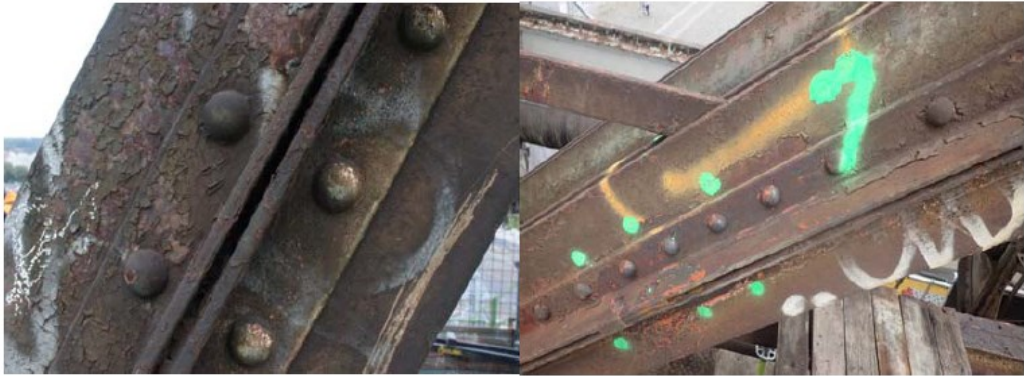
Fotografie zkušebního místa č.1, zleva: před a po tryskání
