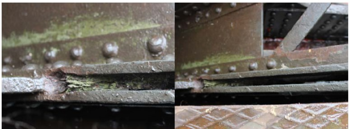
Fotografie zkušebního místa č.2, zleva: před a po tryskání
