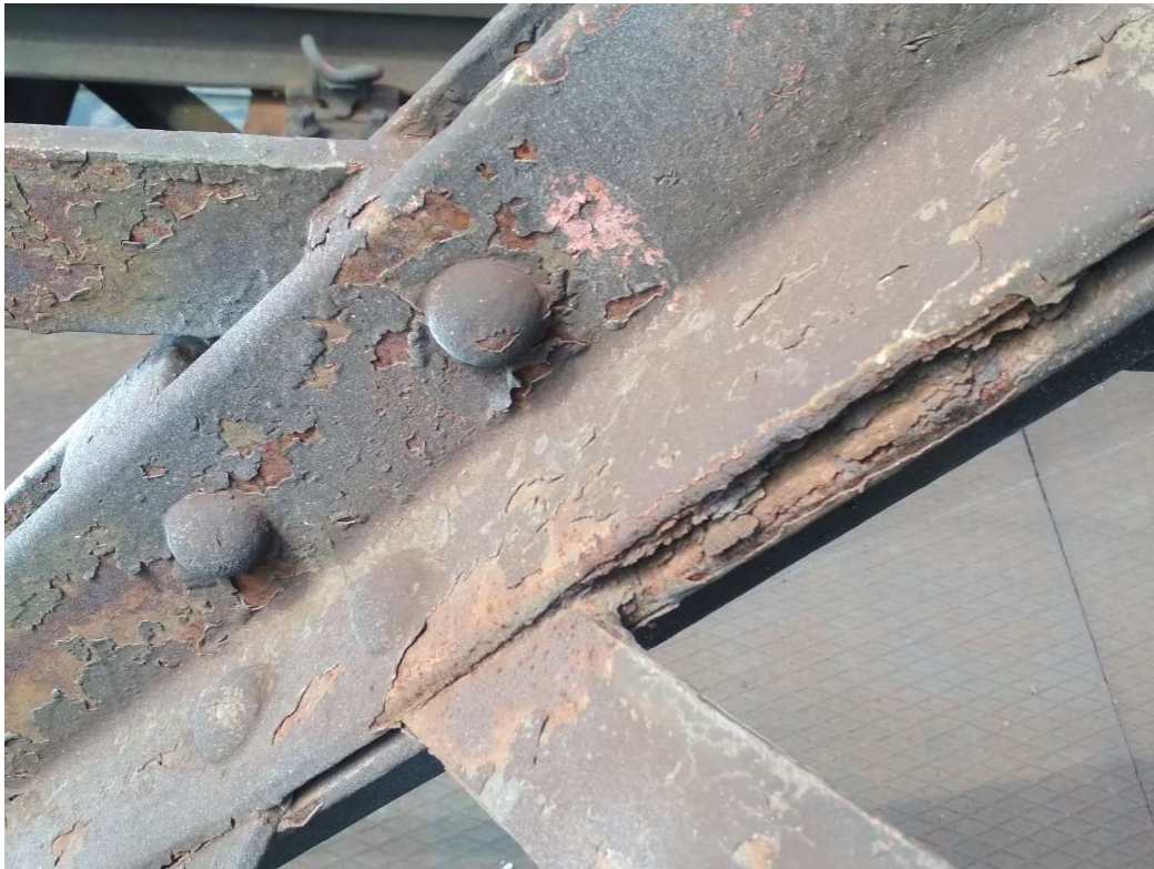
Fotografie neprůchozí štěrbiny v diagonále s těžkým přístupem
