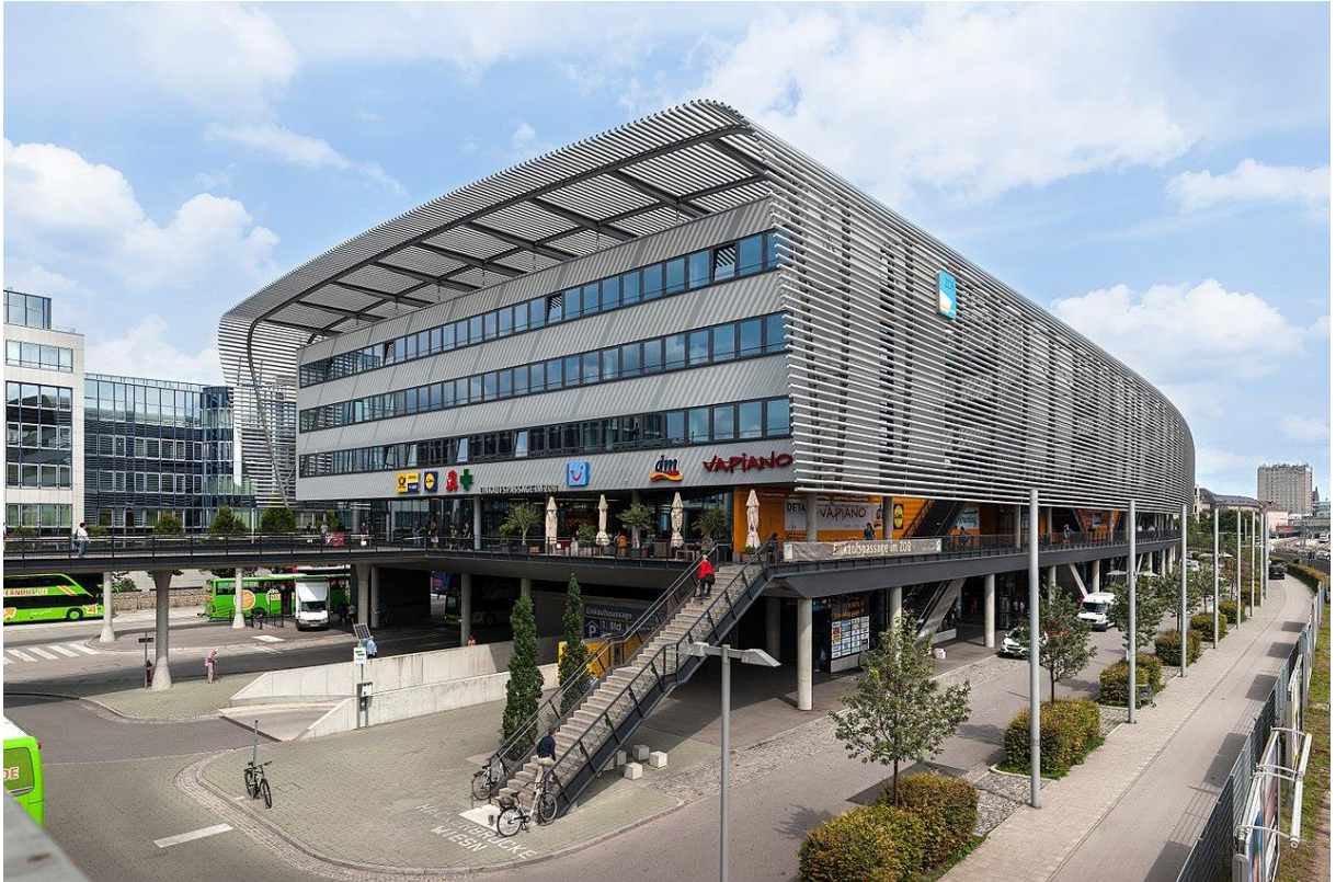
Obrázek 24: Moderní budova má svým pláštěm z hliníkových trubek připomínat čelo německé vysokorychlostní jednotky ICE. (Zdroj: c-w-design.de)
