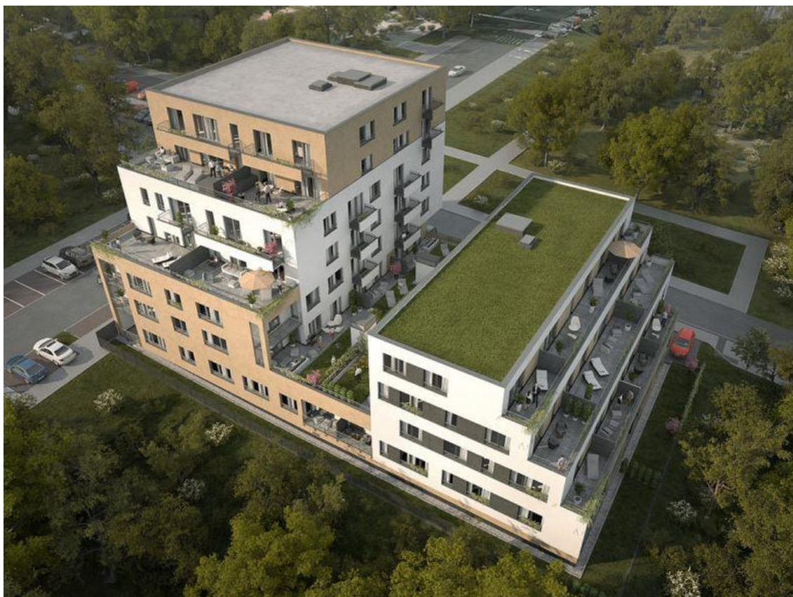
Obrázek 13- Letecký pohled na objekt [9]
