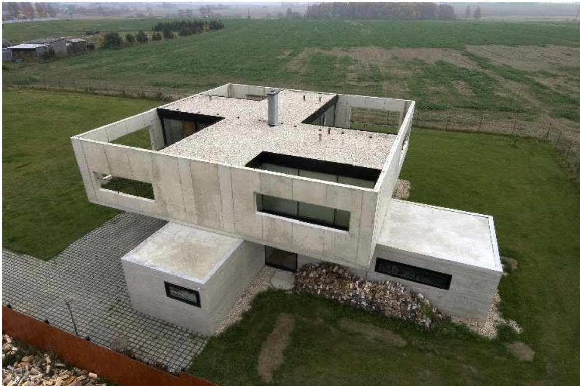
Obrázek 7- Letecký pohled na objekt [10]
