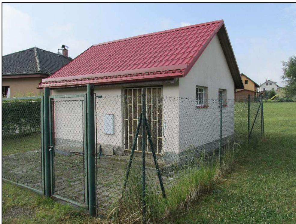
Obr. č. 16 – Objekt vodárny
