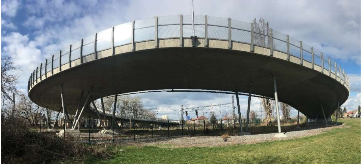
Obrázek 207 - Pohled na most v Poděbradech (foto autor)
