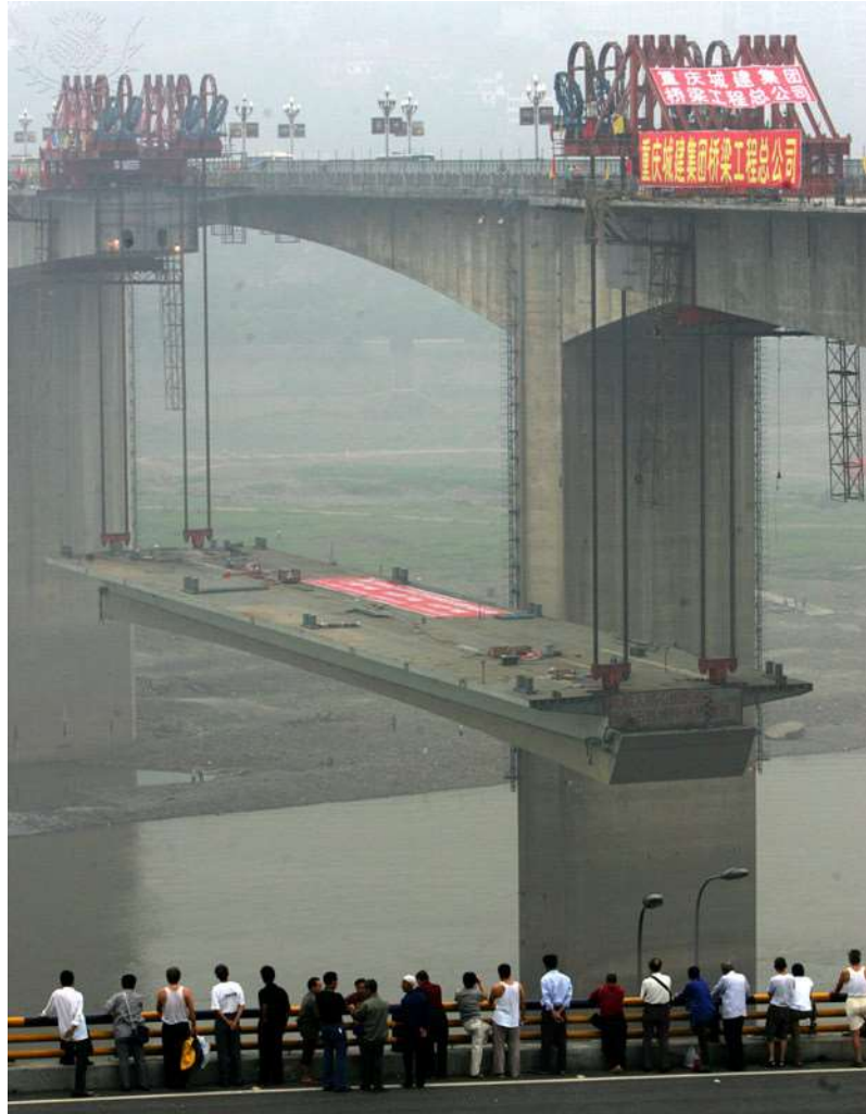
Obrázek 17- Fotografie z průběhu zvedání ocelového segmentu na mostu Shibampo (zdroj [11])
