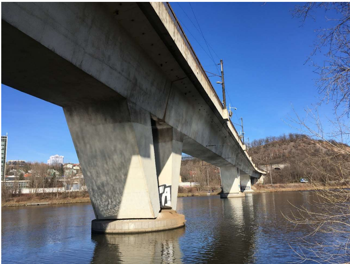
Obrázek 56 - Pohled na konstrukci z břehu (foto autor)
