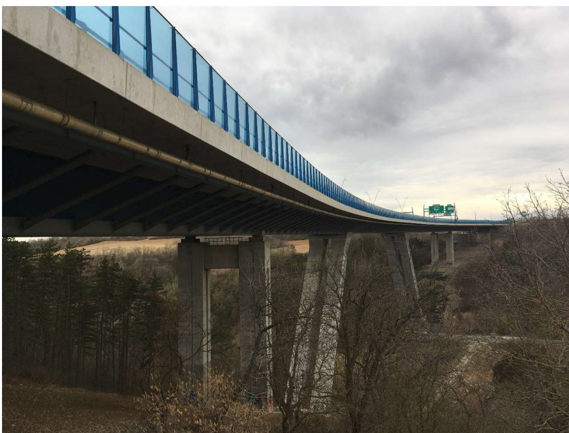
Obrázek 46 - Pohled zespod konstrukce Lochkovského mostu (foto autor)
