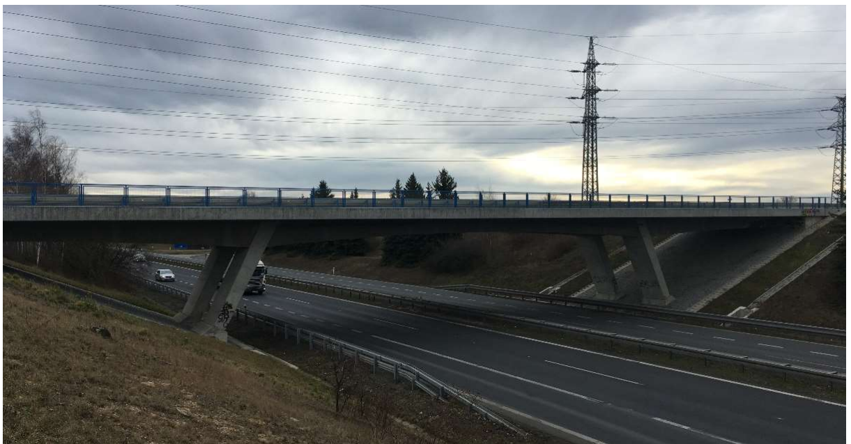
Obrázek 42 - Pohled na vzpěradlový nadjezd u Bouchalky (foto autor)
