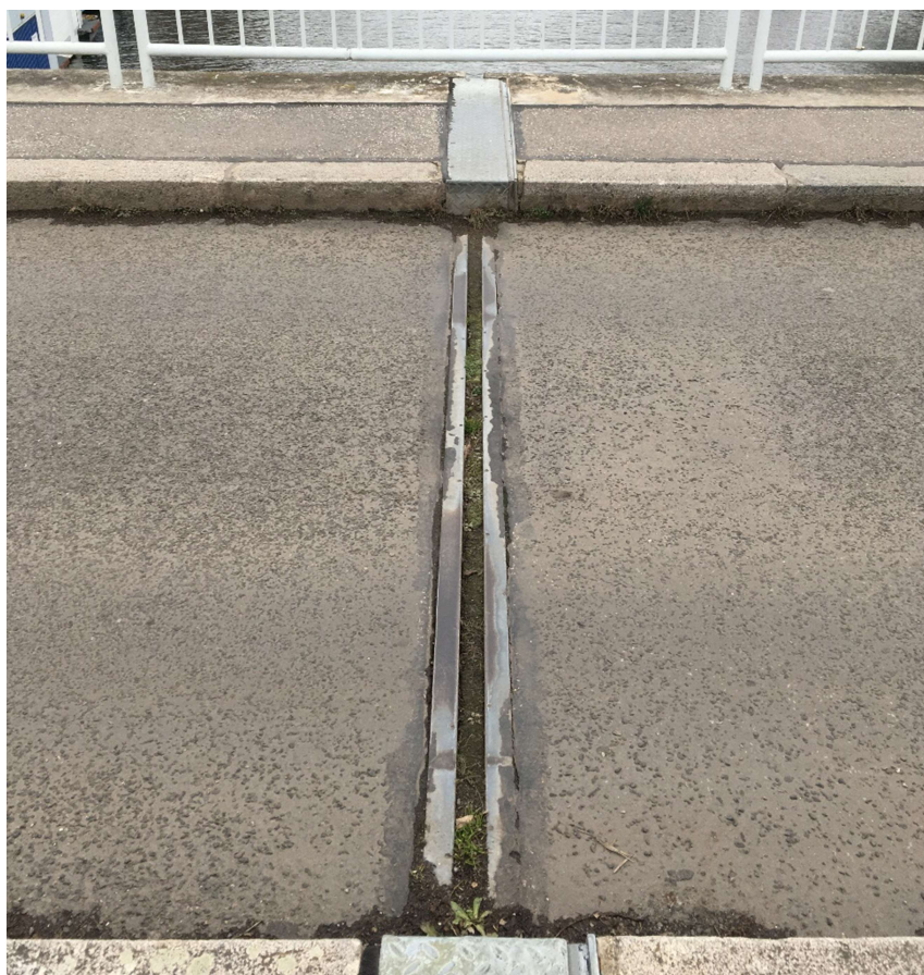
Obrázek 24 - Dilatační spára - most na Veslařský ostrov (foto autor)
