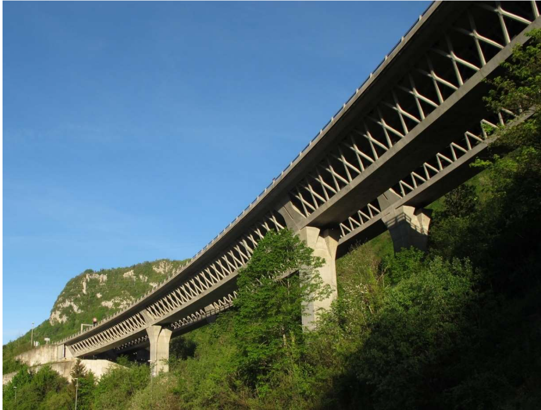
Obrázek 29 - Viadukt Sylans (zdroj [17])
