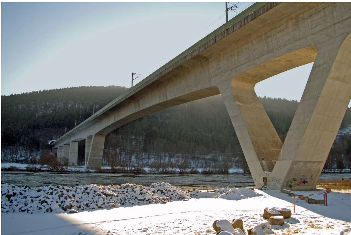
Obrázek 50 - Vzpěradlový železniční most u Gmündenu (zdroj [32])
