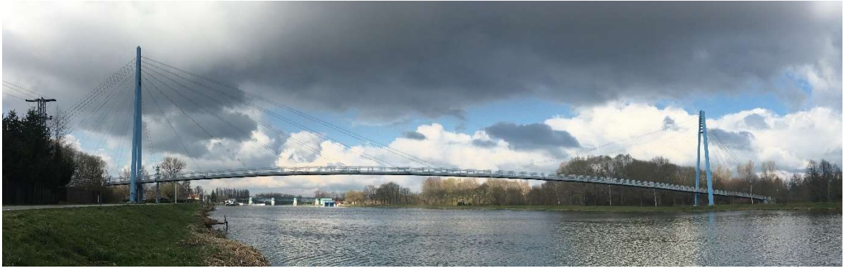
Obrázek 9 - Pohled na lávku v Čelákovících (foto autor)
