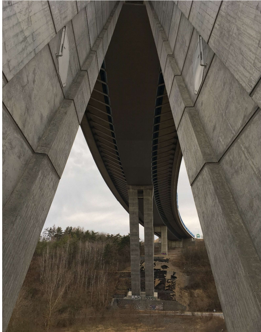
Obrázek 47 - Pohled z prostoru mezi vzpěrami (foto autor)
