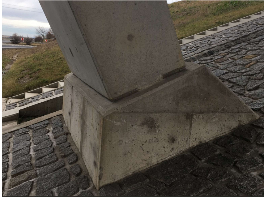
Obrázek 44 - Detail vrubového kloubu (foto autor)
