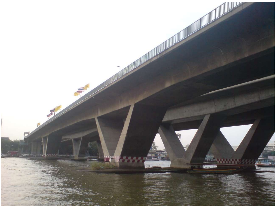
Obrázek 49 - Pohled na konstrukci Taksin bridge (zdroj [30])
