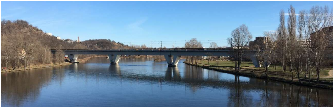
Obrázek 54 - Pohled na konstrukci z mostu Barikádníků (foto autor)
