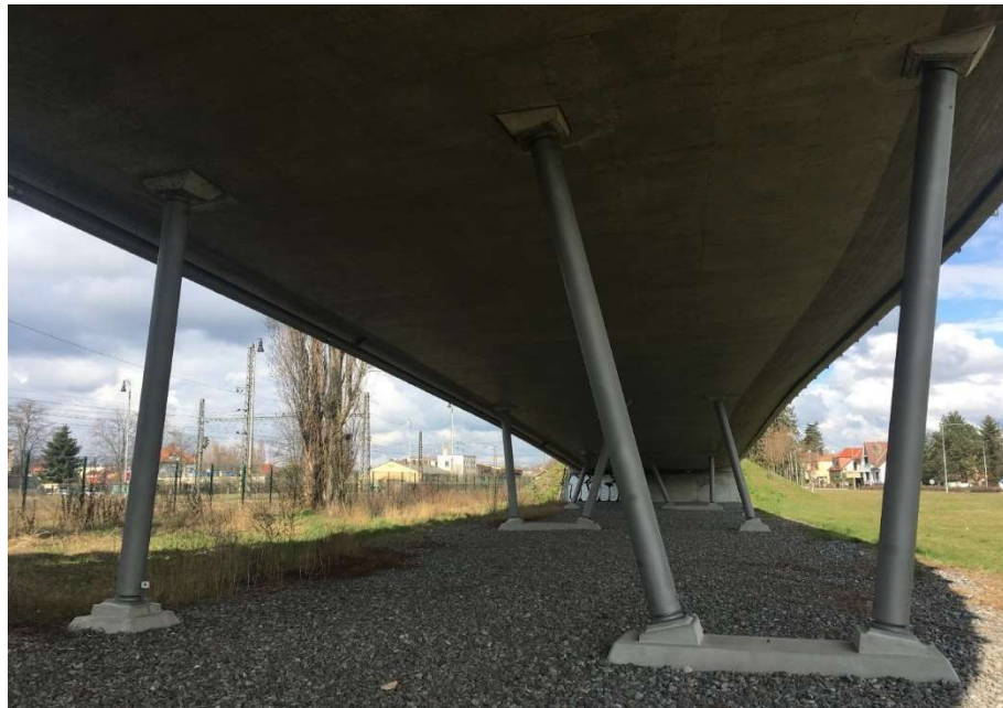
Obrázek 208 - Kynné stojky použité na mostu v Poděbradech (foto autor)
