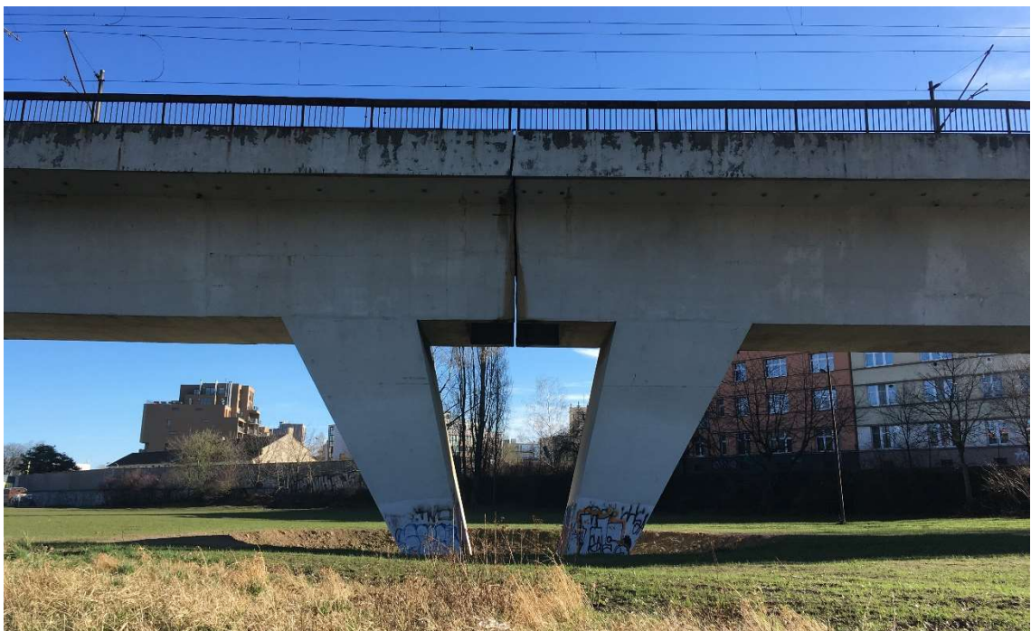
Obrázek 55 - Pohled na styk dvou ráků (foto autor)
