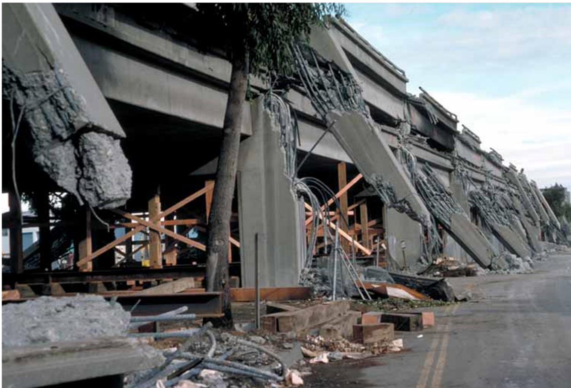
Obrázek 3: Kolaps pilířů (4)
