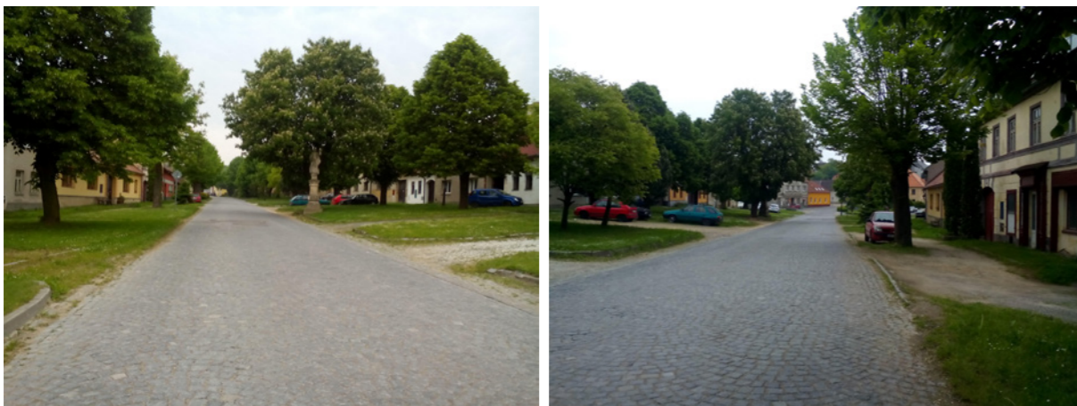
Újezdecká ulice před rekonstrukcí v roce 2019
