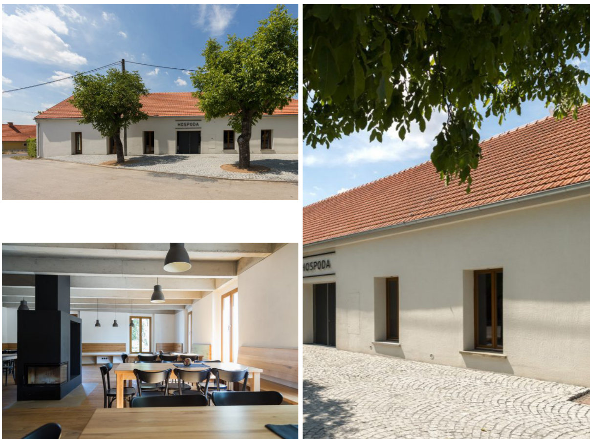
Tradiční materiály, střídá fasáda. Použití francouzských oken na návsi. Ž-B trémový strop. ATELIER BOD ARCHITEKTI s.r.o., REKONSTRUKCE HOSPODY SE SÁLEM V MÁŠLOVICÍCH
