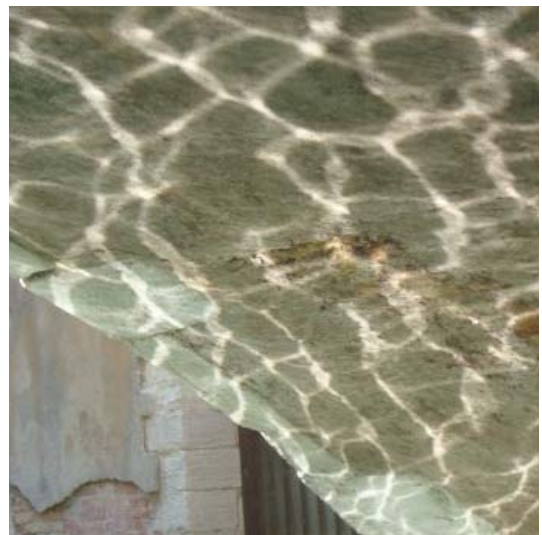
ODRAZ VODY NA STAVBU
