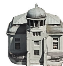
2. Vodní elektrárna, Štvanice
