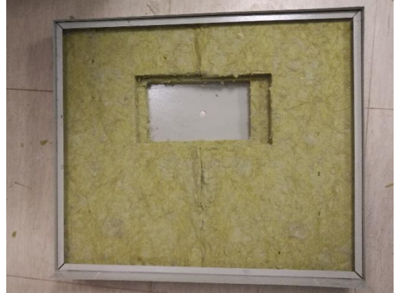
Nová izolace - obr. 31
