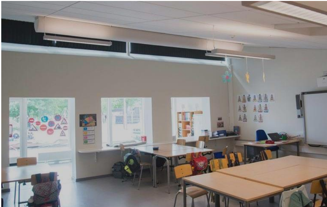
Obr. 21 Půlkruhová textilní vyústka v učebně školy Baaring Denmark [14].
