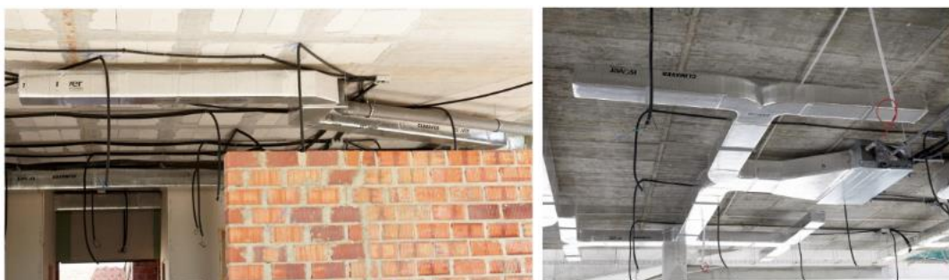
Obr. 27 Využití potrubí Climaver ve vzdělávacích stavbách ve Španělsku. Důvody pro výběr systému jsou akustické požadavky, finanční úspory a úspory energie [18]
