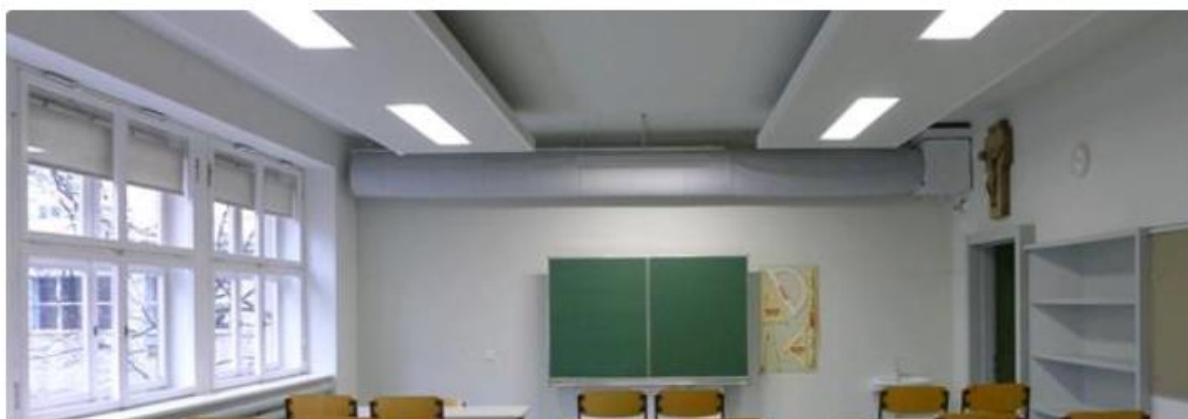
Obr. 20 Použití textilních rukávců při větránírekonstruovaných škol [13].
