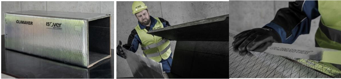
Obr. 25 Montáž potrubí z panelu [17]
