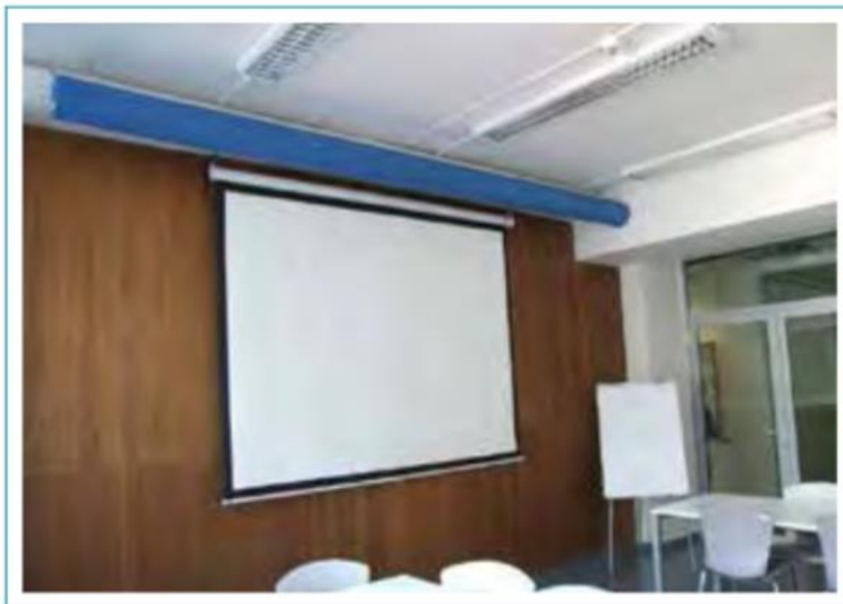
Obr. 18 Textilní vyústka v konferenční místnosti. Fakulta stavební ČVUT v Praze [11]
