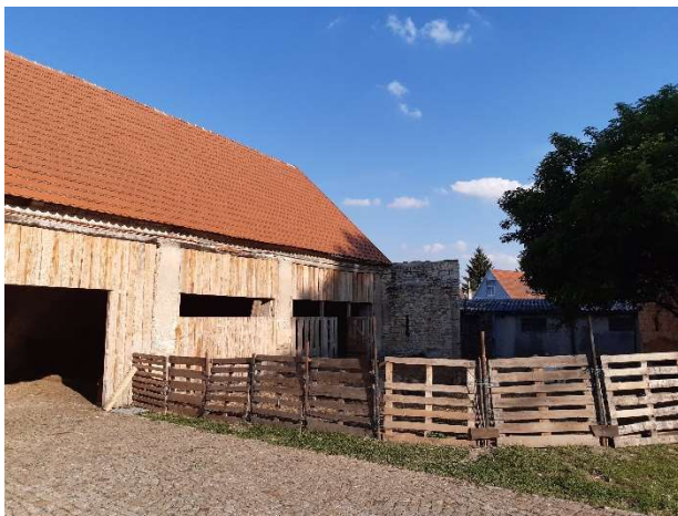
Obrázek 19. Současný stav. Hospodářská budova na východ od plánované stavby. (Zdroj: autorka práce, 2020.)
