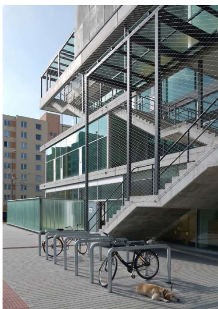
Obrázek 15. KC České Budějovice. Východní fasáda a schodiště. (Zdroj: SLLA Architects, 2012.)
