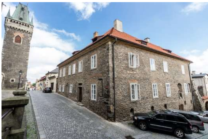
Obrázek 10. KC Kolín. Pohled z jihovýchodu. (Zdroj: Tomáš Hladík, srpen 2014.)
