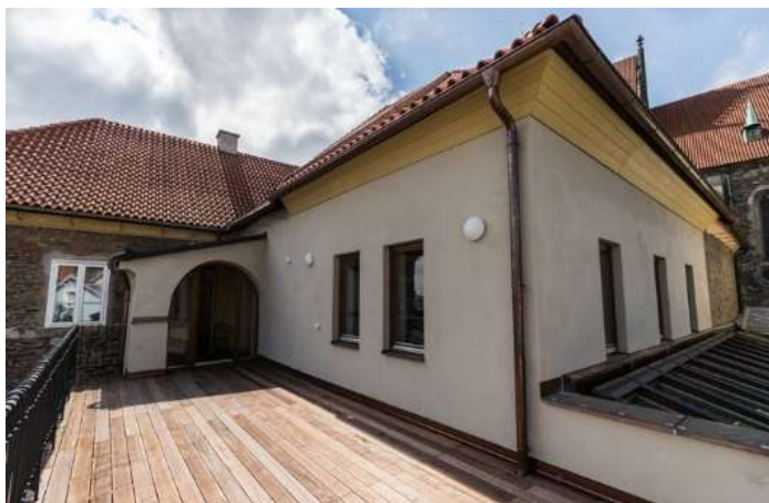
Obrázek 11. KC Kolín, přístavba. (Zdroj: Tomáš Hladík, 2014.)
