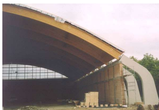
Obr. 30 - Hala VUT Brno [25]
