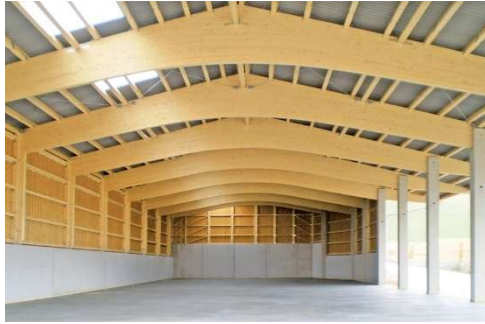
Obr. 49 - Lepený sedlový vazník [20]
