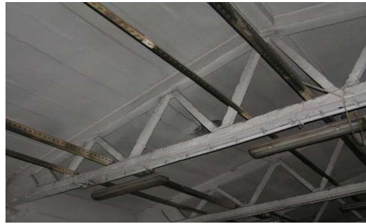
Obr. 56 - Příhradový ŽB nosník [47]
