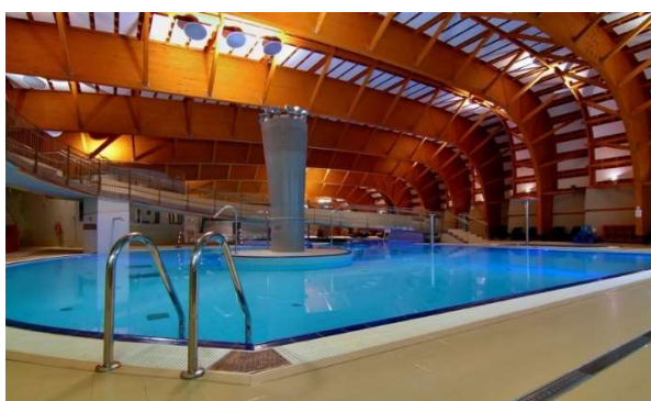
Obr. 43 - Dvoukloubová rámová hala - Brno [30]
