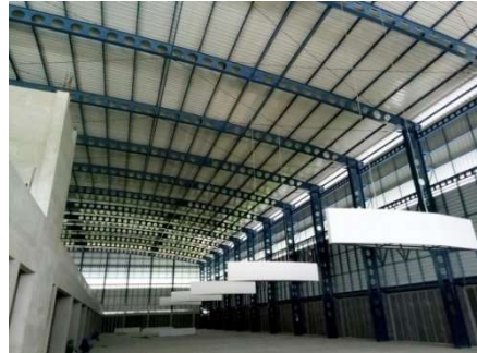
Obr. 50 - Ocelový prolamovaný vazník [21]
