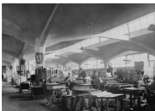
Obr. 44 - Rámová konstrukce střechy - Továrna v Novém Městě nad Váhom [32]
