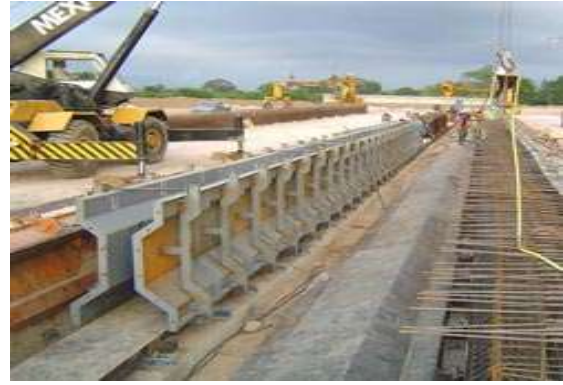
Obr. 62 - Skládání formy na předpjaté vazníky
