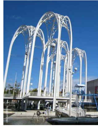
Obr. 22 - Betonová příhradová oblouková konstrukce – Seattle [40]
