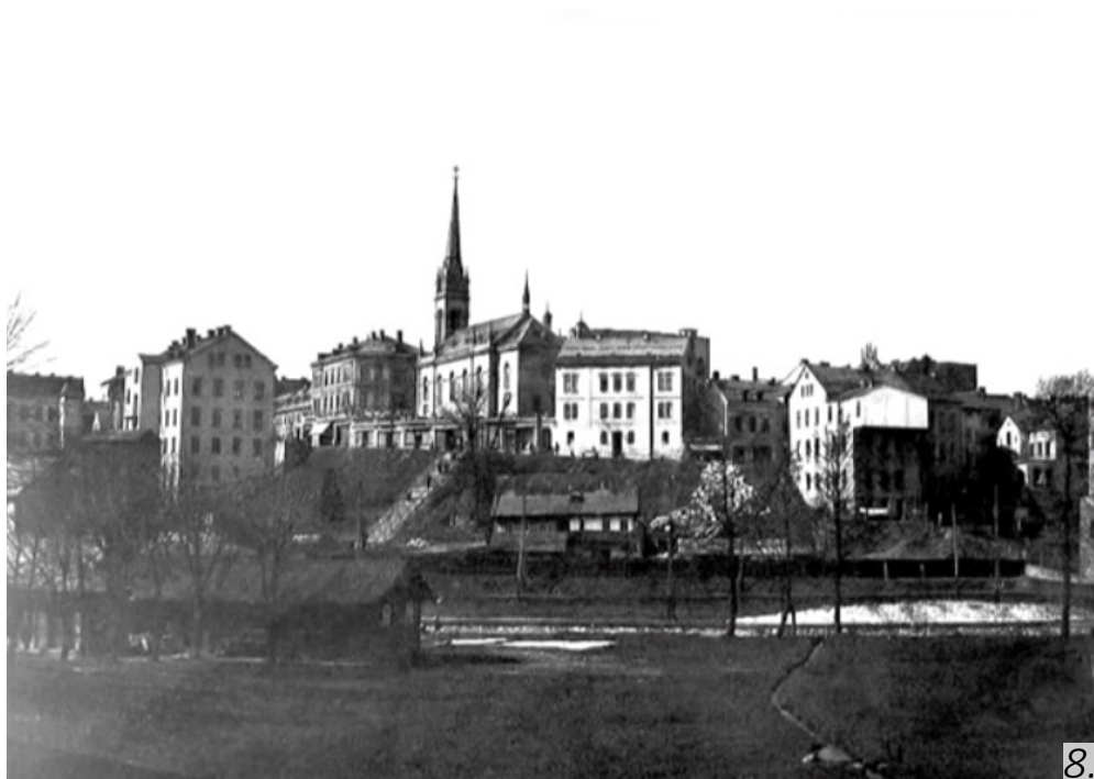
Pohled na zatím nedostavěnou Podhorskou ulici zezadu z místa mezi Nisou a ulicí 5. května
