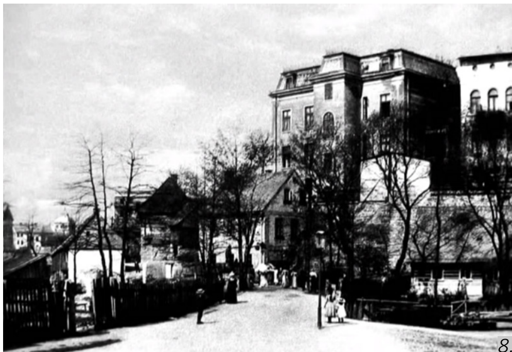
Pohled z lokality dnešního autobusového nádraží do ulice Lipanská. Vidět jsou dále budovy v Jiráskově ulici již v dnešní podobě.
