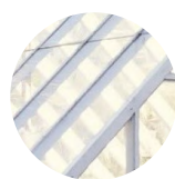
bílá ocelová konstrukce
