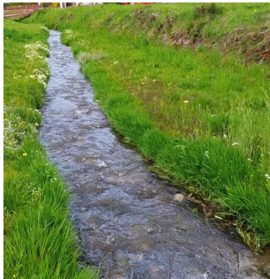
Obr. 10 - Upravené zatravnené koryto v intraviláne obce
