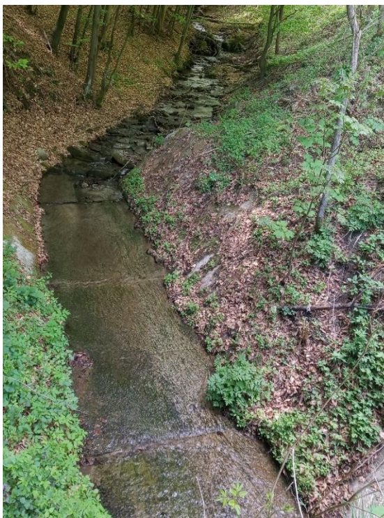
Obr. 25 - Spevnené dno koryta
