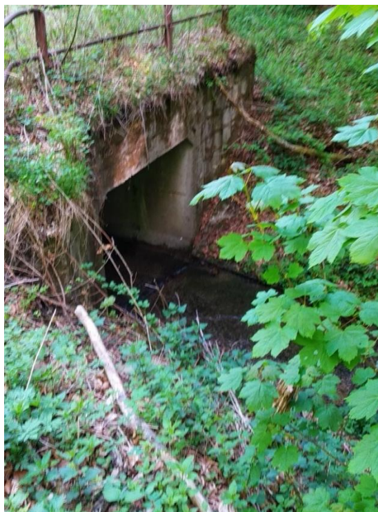
Obr. 26 - Rámový priepust na výtoku
