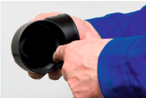
5) Vnitřní povrch kolena namažeme kluzným přípravkem*.
