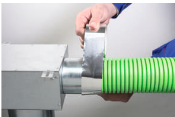
7) Spoj zajistíme vzduchotěsnou lepicí páskou.
