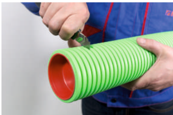
1) Trubku zkrátíme na požadovanou délku v úžlabí korugace.
