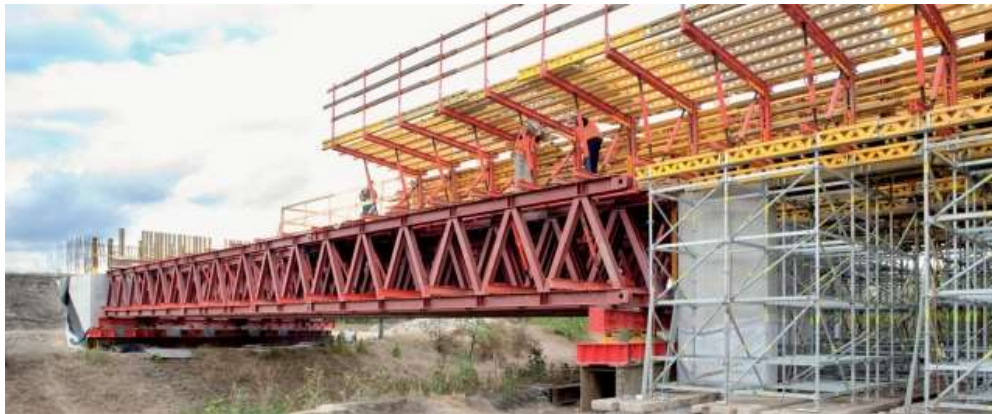
Obrázek 188 Příhradové nosníky PERI KMT [35]
