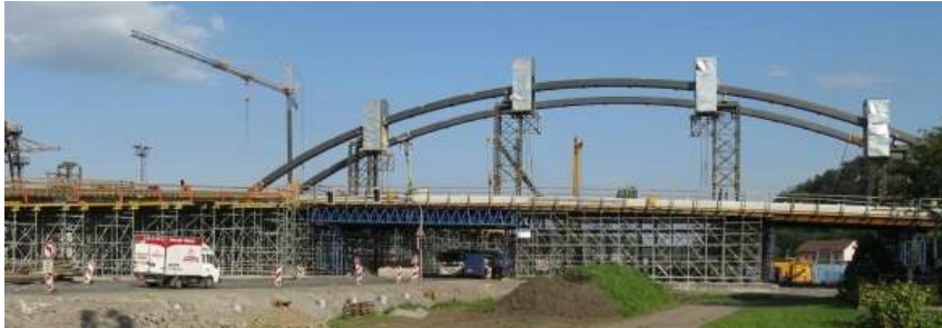
Obrázek 37 Pevná skruž mostu v Trinci-Balinách [11]
