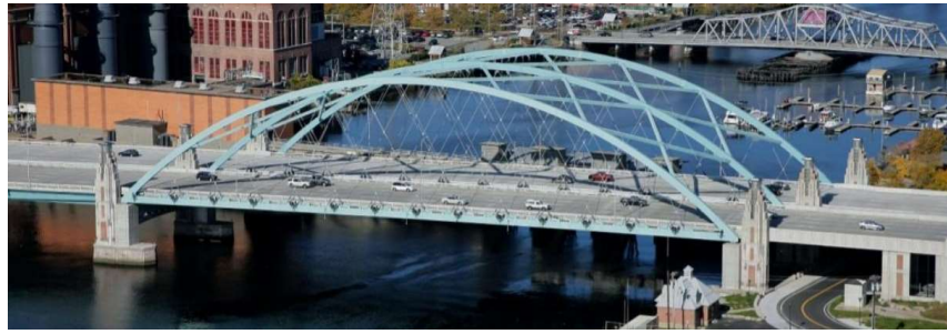
Obrázek 43 Providence bridge v USA [12]
