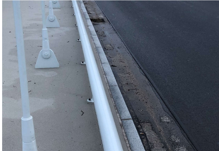
Obrázek 52 Ochrana závěsů trubkovým profilem
