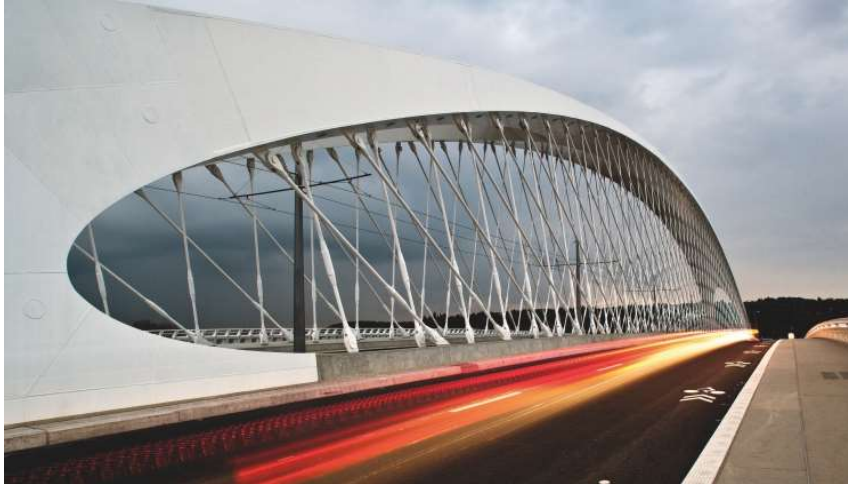
Obrázek 68 Trojský most - pohled na závěsy [23]
