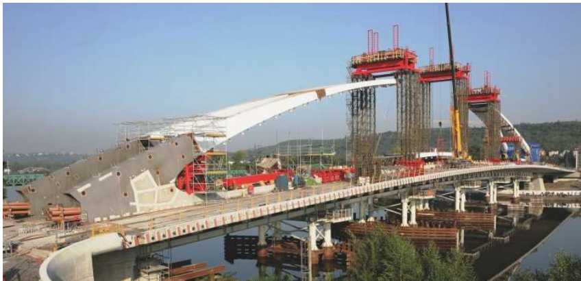
Obrázek 69 Trojský most při montáži ocelových oblouků [23]
