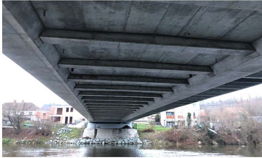
Obrázek 64 Svinarský most - spodní pohled na mostovku
