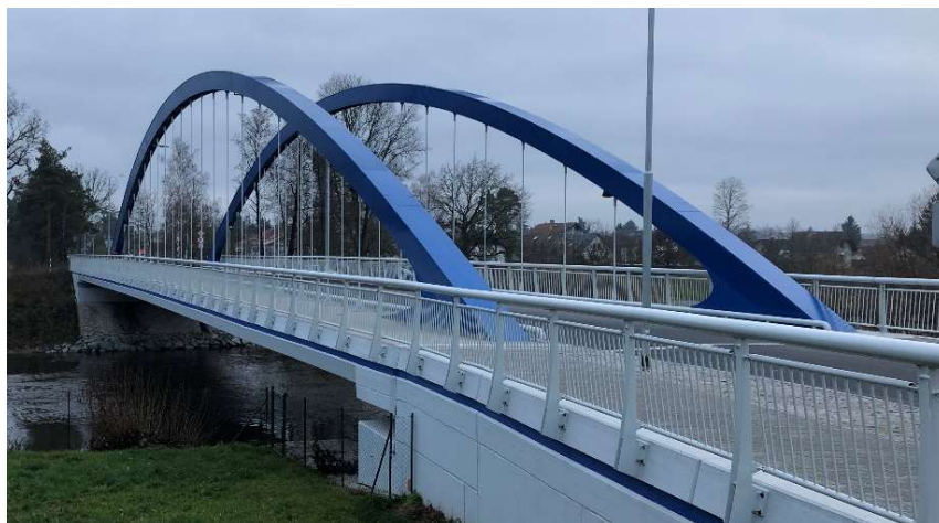
Obrázek 62 Svinarský most přes řeku Orlici
