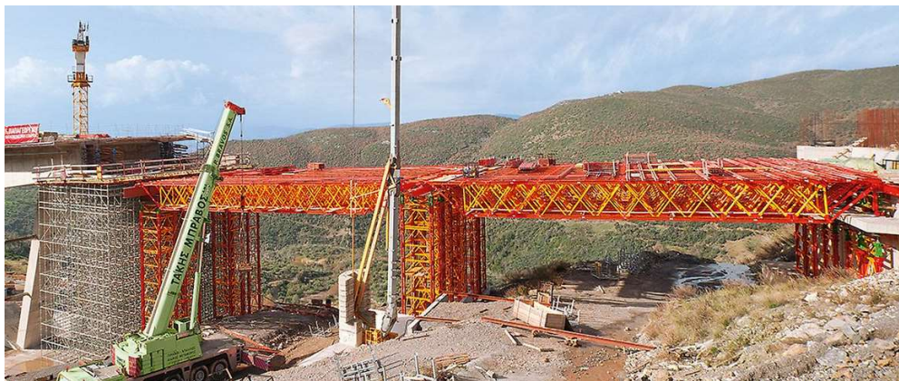
Obrázek 189 Příhradové nosníky PERI VARIOKIT VRB [36]
