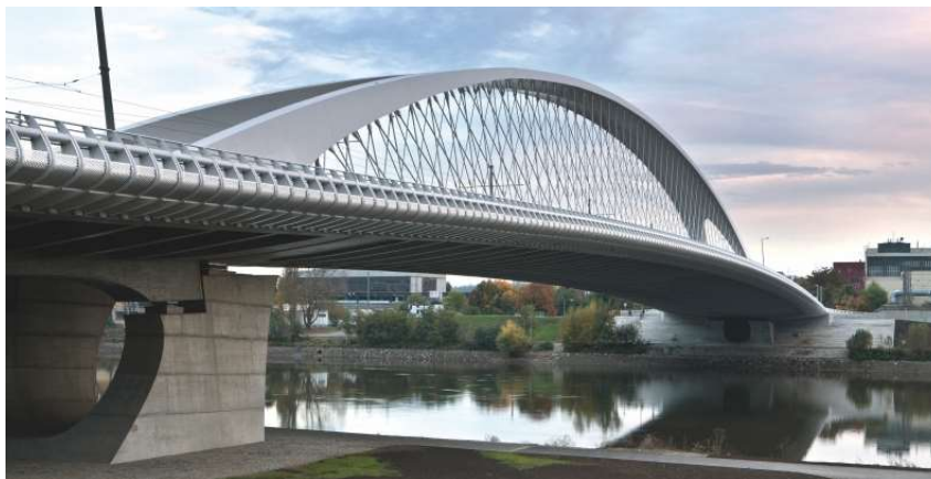
Obrázek 66 Trojský most – společný pilíř hlavního a vedlejšího pole [23]
