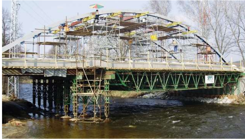
Obrázek 58 Most v Roudném během výstavby [19]
