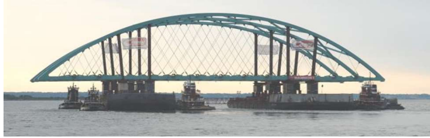
Obrázek 39 Technologie zaplavování u Providence bridge v USA [8]
