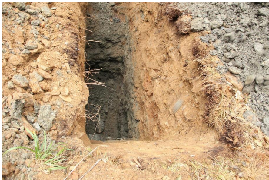
Obr. 10: Sonda S3 v tělese hráze (foto František Vackář)
