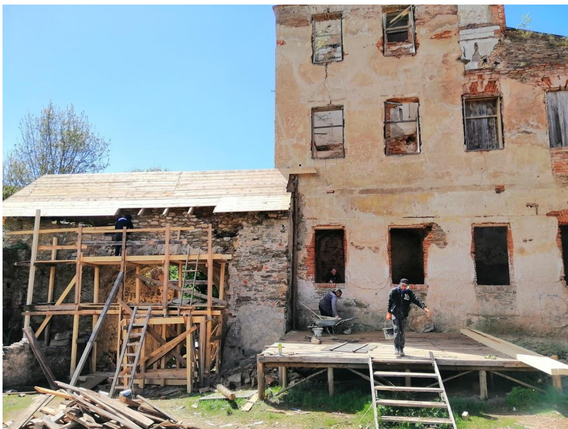
Obr. 9 Neustále probíhající práce na obnově hradu (foceno 1.5. 2020)
