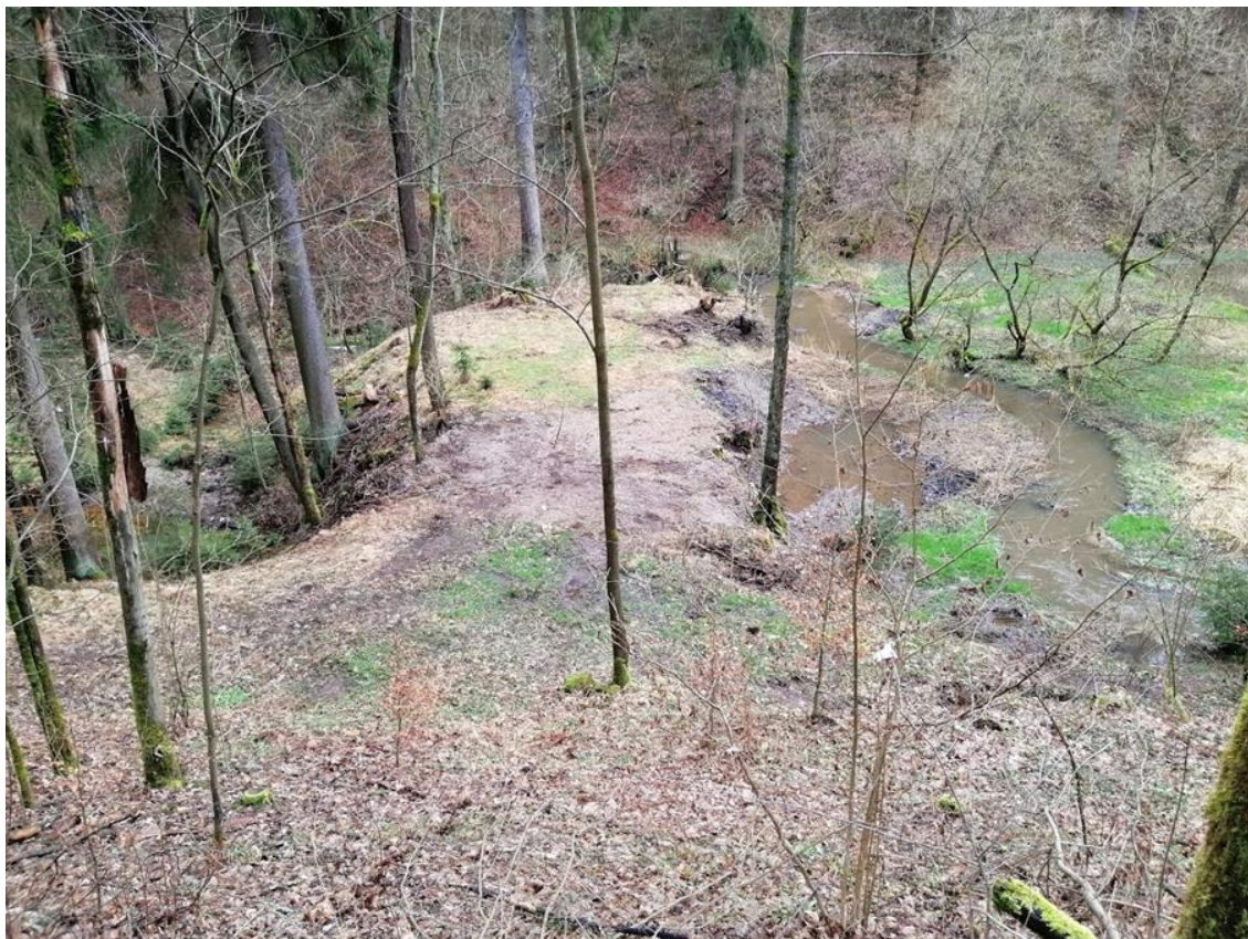
Obr. 18: Pohled na korunu hráze z levého břehu
