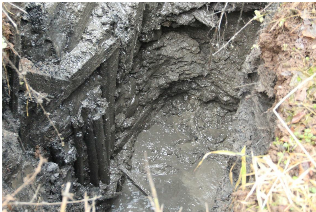
Obr. 11: Zbytky původního požeráku v sondě S4 (foto František Vackář)
