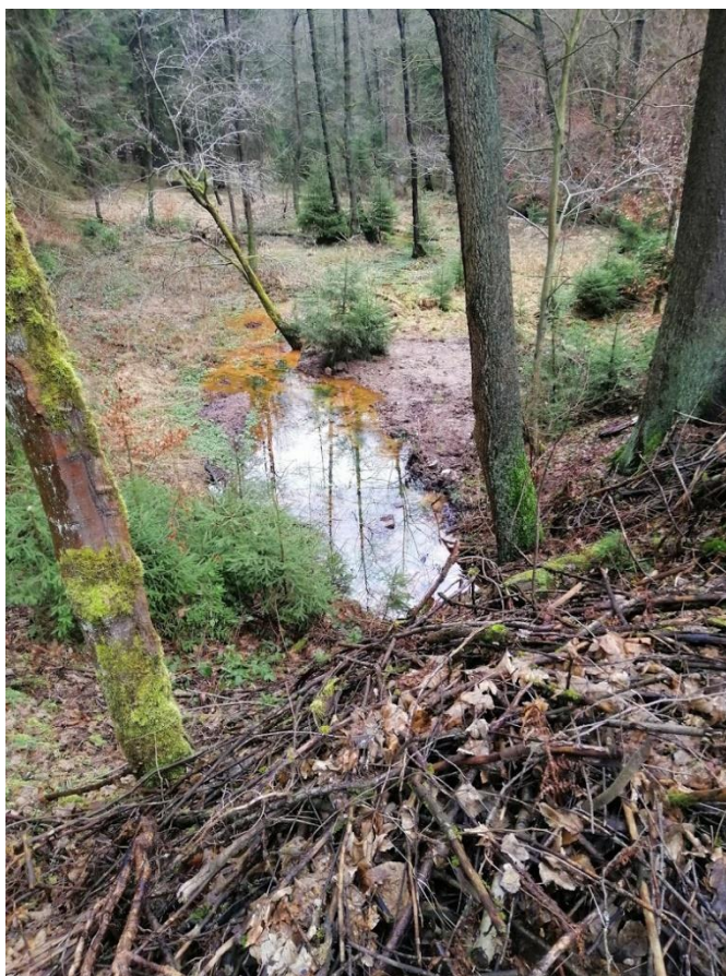
Obr. 15: Průsak pod hrázi v místě bývalé spodní výpusti
