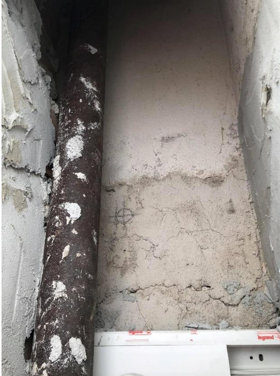
Obr. č. 43: Umístění prostupu z interiéru do exteriéru uvnitř kolektoru
