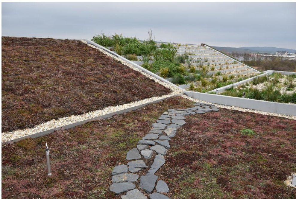
Obr. č. 40: Kamenné šlapáky na střeše výrobní haly firmy LIKO-S
