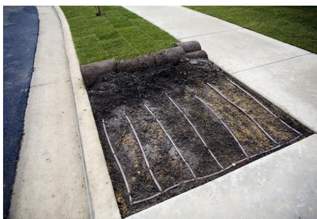
Obr. č. 62: Realizace podzemního kapkovacího potrubí ROOTGUARD MULTIBAR [41]
