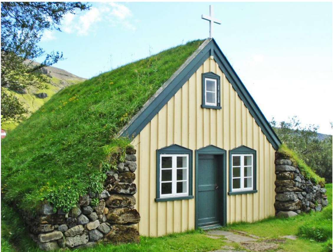
Obr. č. 5: Kostel Hofskirkja [48]
