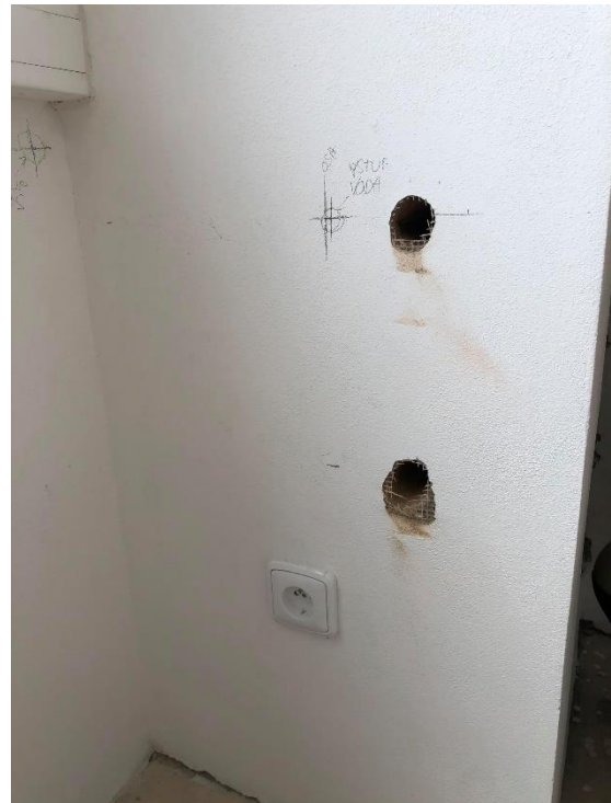
Obr. č. 44: Realizované prostupy pro přívod vody do AZS
