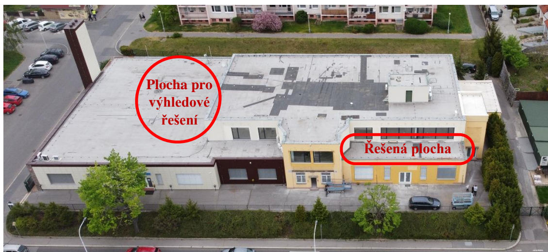
Obr. č. 27: Širší pohled na objekt s vyznačením řešených ploch v rámci práce (foto: Ing. Lukáš Mihula)
