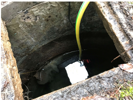
Obrázek 14: Čerpání vody
