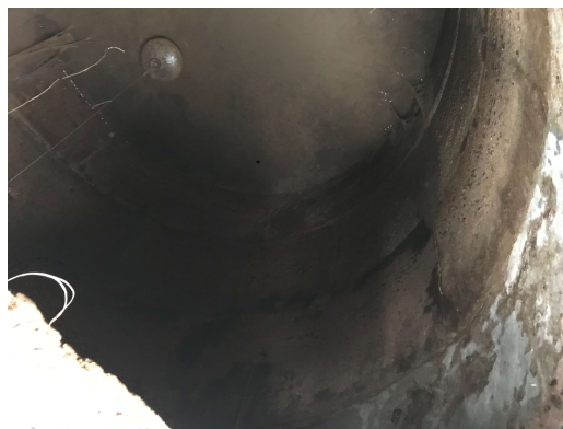
Obrázek 13: Studna s průměrem 2 m
