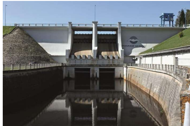
Obrázek 1 - Hráz nádrže Lipno [9]
