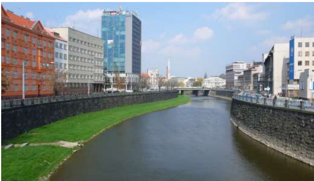
Obrázek 11 – Příklad jalové bermy v korytě řeky Radbuzy v centru Plzně Dostupné z: http://www.povis.cz/pre/2015_oov/material_aopk.pdf
