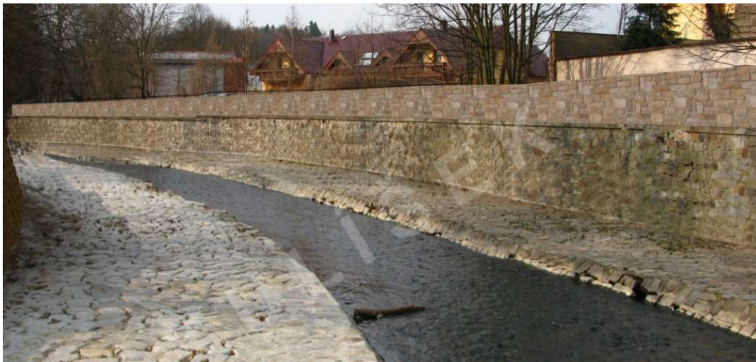
Obrázek 26 – Vizualizace úpravy koryta pomocí ochranných zídek
