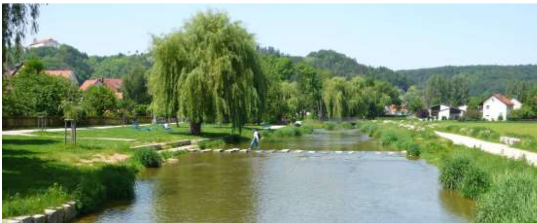
Obrázek 14 – Přírodě blízká úprava koryta řeky Sulz ve městě Beilngries v Bavorsku Dostupé z: http://www.povis.cz/pre/2015_oov/material_aopk.pdf
