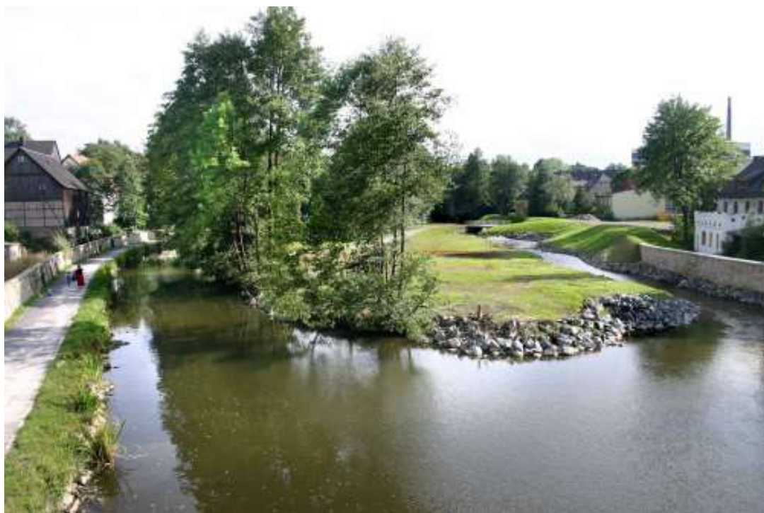
Obrázek 10 – Schwarzenbach u Hofu, Bavorsko – Příklad intravilánové revitalizace, tvarově a hydraulicky členitý prostor koryta se stezkou pro pěší posiluje ekologickou funkci i rekreační využitelnost, kapacita koryta zvýšená krajními ochrannými zdmi a valy zajišťuje dostatečnou ochranu okolní zástavby (19). Dostupné z: http://www.povis.cz/pre/2015_oov/material_aopk.pdf
