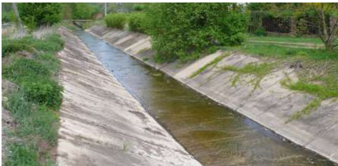
Obrázek 5 – Příklad technické úpravy koryta toku ve Všenorech (19) Dostupné z: http://www.povis.cz/pre/2015_oov/material_aopk.pdf
