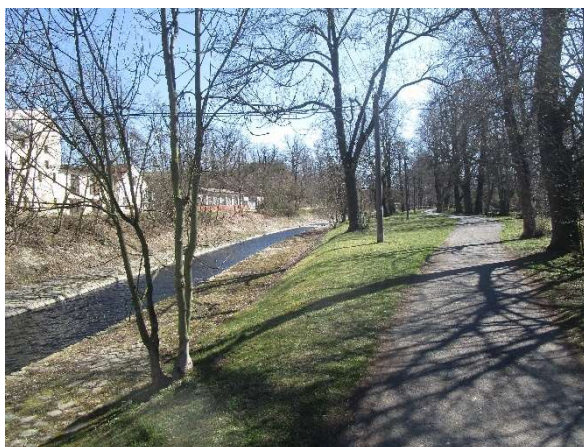
Obrázek 30 – Úsek mezi jezem a železničním mostem – Bod č. 2 Zdroj: Autorská fotografie
