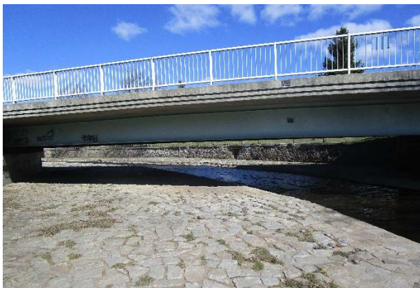
Obrázek 33 – Most v ulici Soukenická – Bod č. 5 Zdroj: Autorská fotografie
