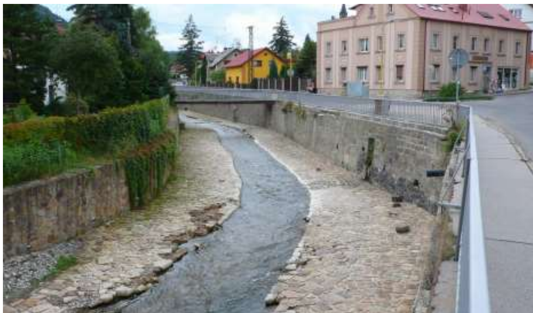
Obrázek 6 – Velmi podobný způsob technické úpravy koryta řeky v urbanizovaném území, jako byl použit na řece Klabavě v Rokycanech, tentokrát v Jílovém u Děčína. Dlážděná, hladká kyneta s minimální členitostí a velkou rychlostí proudící vody a dlážděné, ploché jalové bermy bez jakékoliv zeleně způsobují nulovou ekologickou hodnotu toku. Prostorové uspořádání neumožňuje rozšíření toku do stran, ekologickou funkci lze podpořit například zvýšením členitosti geometrie a povrchu bermy a kynety (19).
