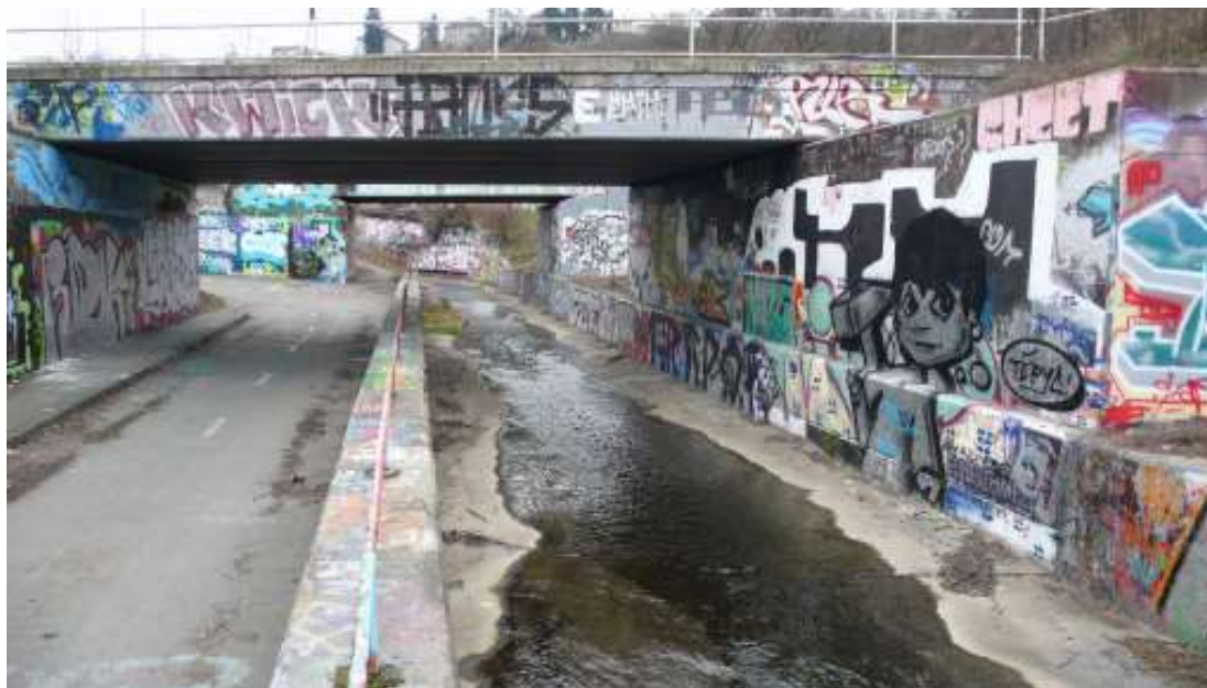
Obrázek 4 – Příklad tvrdých technických protipovodňových opatření na Dalejském potoce v Hlubočepích (19).
