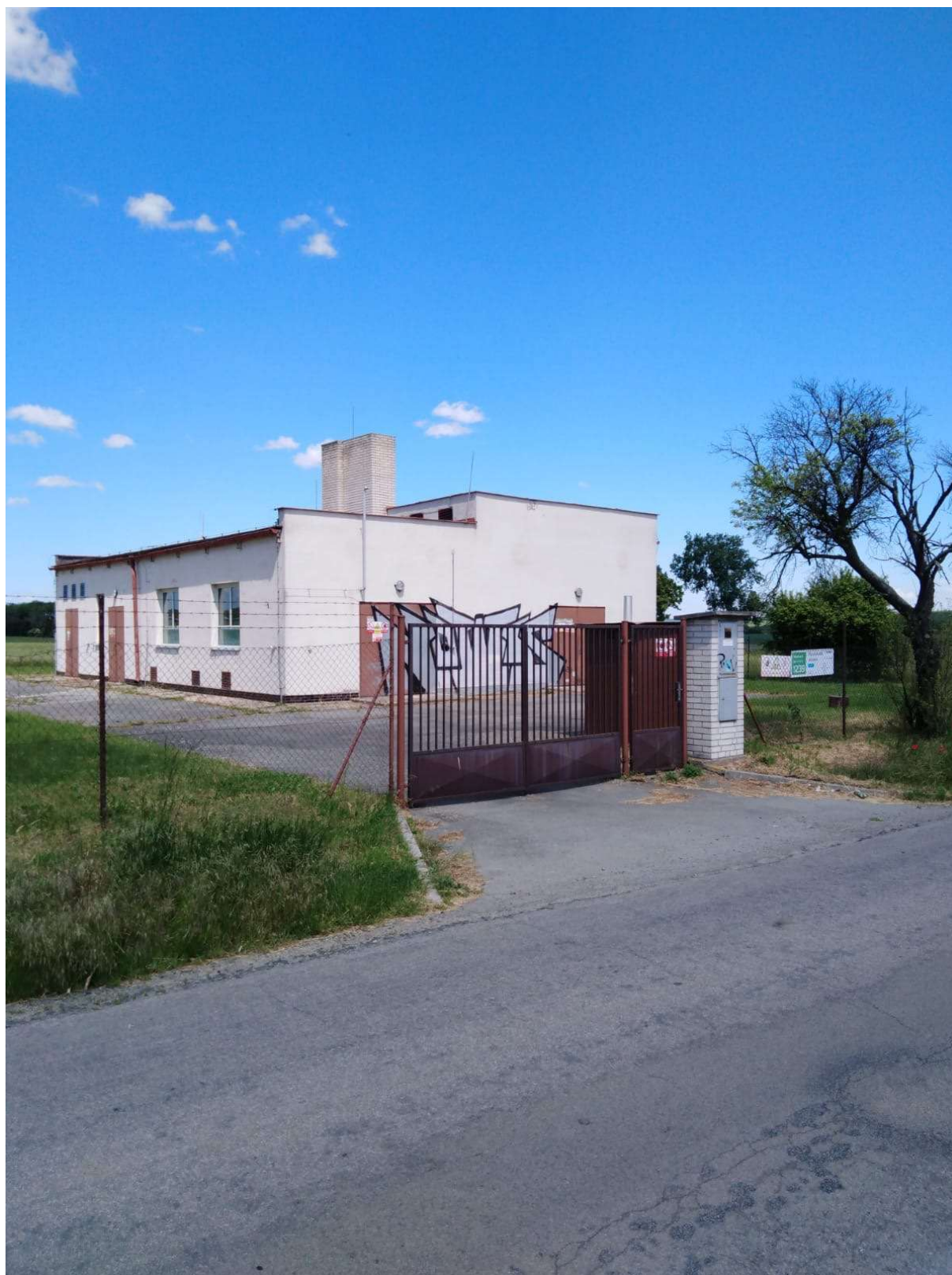
Obrázek 13 Regulační stanice na silnici III/01013 (směr na Strašnov)
