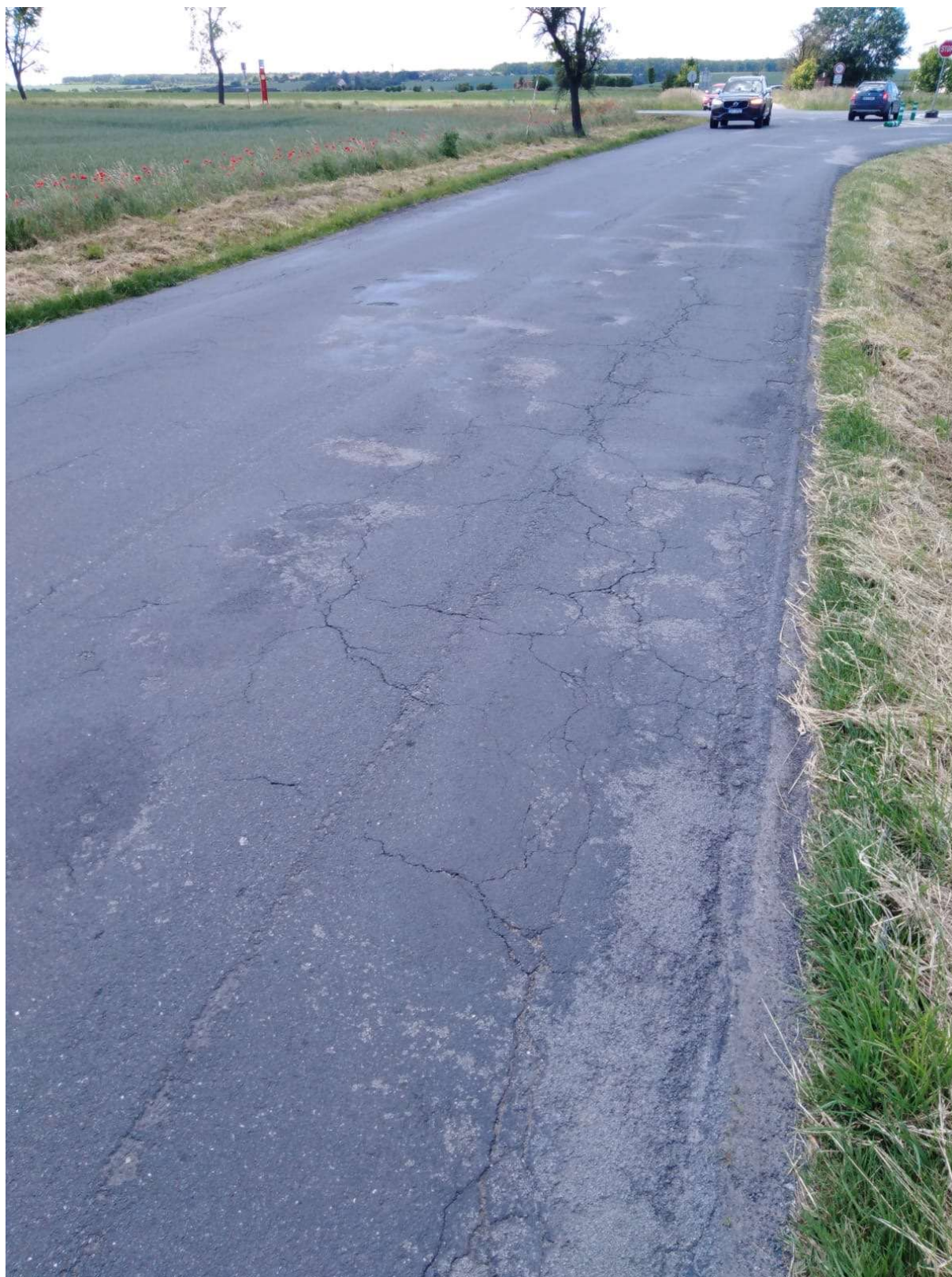
Obrázek 11 Podélné a příčné trhliny na silnici III/01013 (ze směru Nepřevázka)
