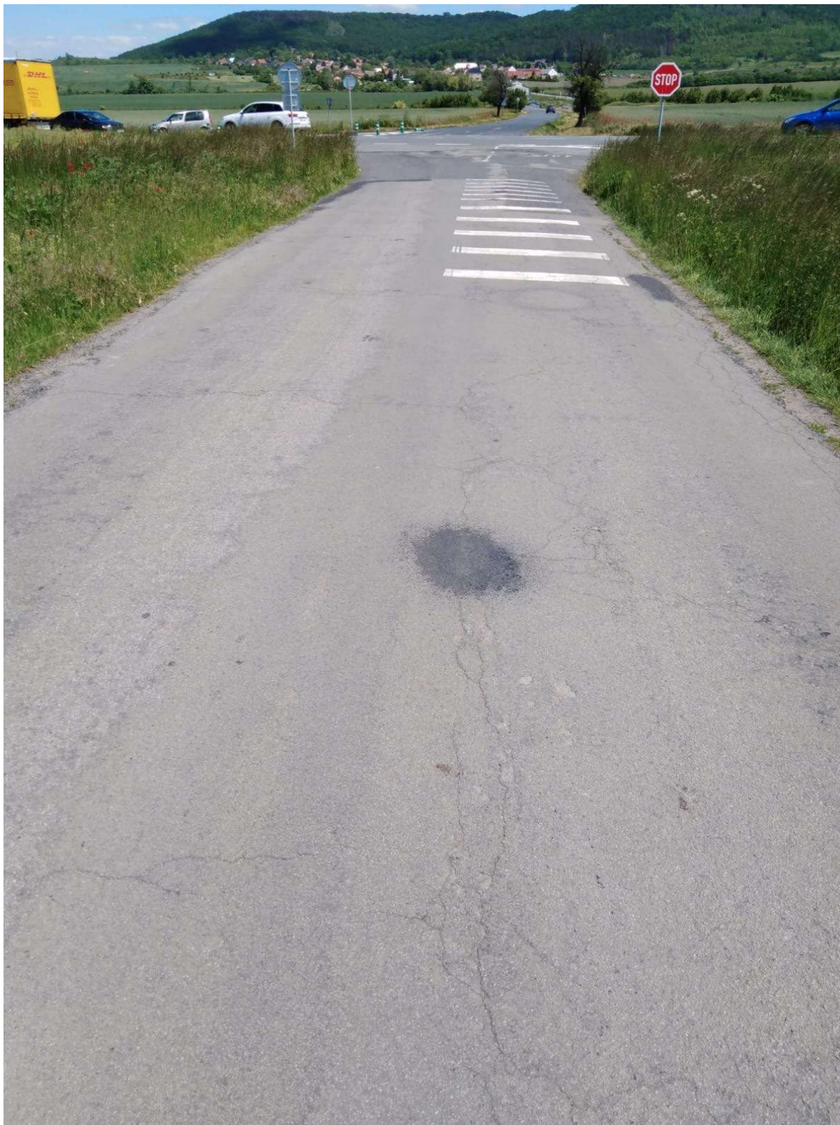
Obrázek 12 Podélné a příčné trhliny na silnici III/01013 (ze směru Strašnov)
