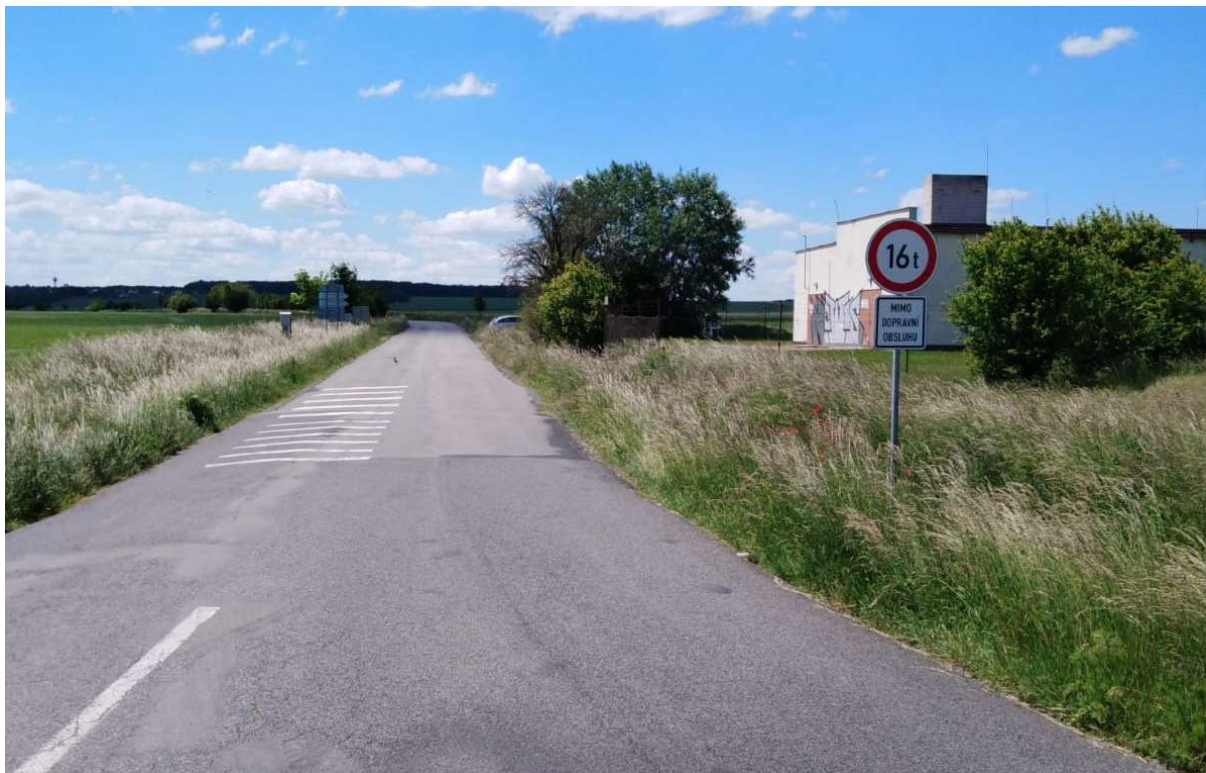
Obrázek 5 Současný rozhled z napojení I/38 na III/01013 (směr na Strašnov)
