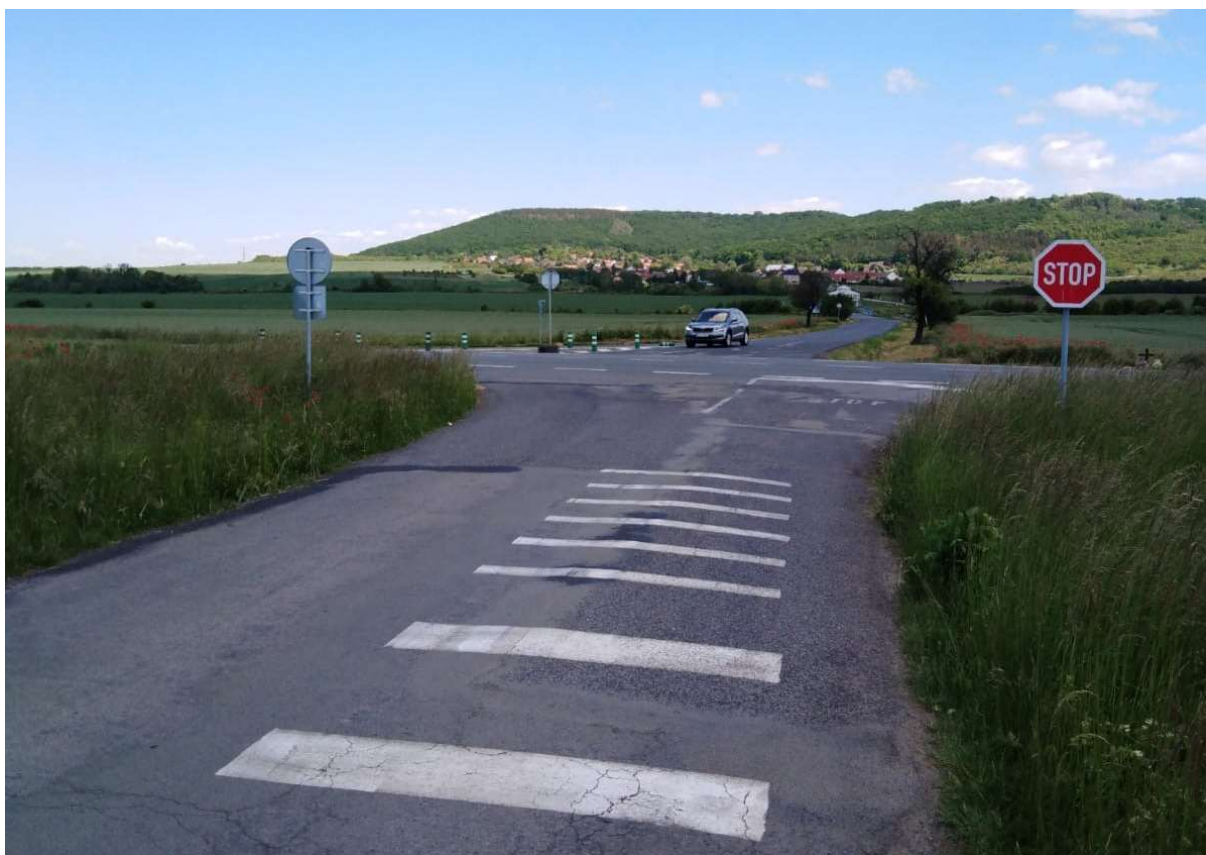
Obrázek 3 Pohled na současné křižení I/38 s III/01013 (ze směru Strašnov)
