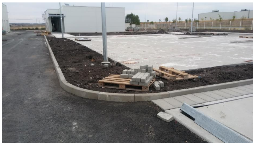
Obrázek 44: Parkoviště ze zámkové dlažby, rozvezená ornice a spodní vrstva asfaltového krytu [archiv autora]
