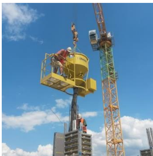
Obrázek 24: Betonáž bádí s plošinou [www.profi-bau.cz]
