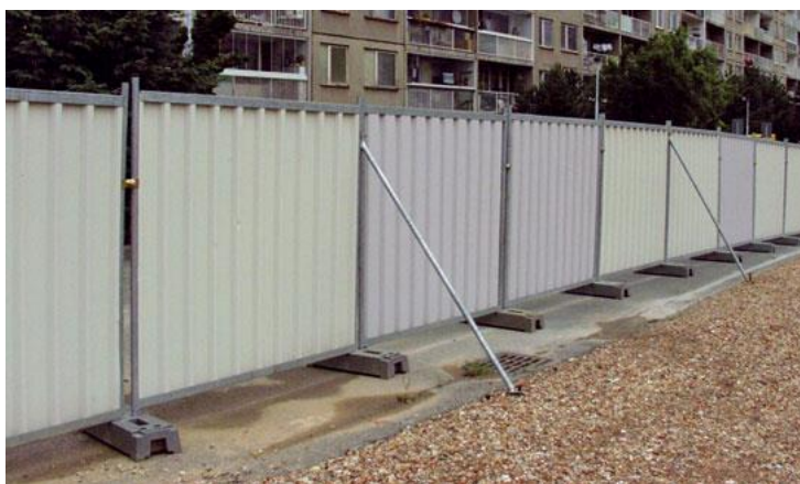
Obrázek 4: Způsobe oplocení stavby neprůhlednými plotovými dílci [www.asb-portal.cz]
