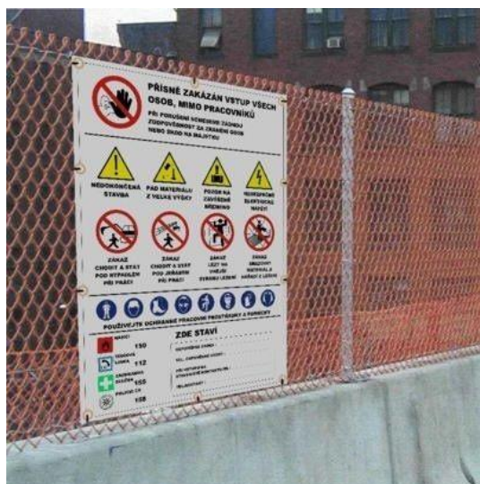
Obrázek 7: Informační tabule u vstupu na staveniště [www.e-safetyshop.eu]
