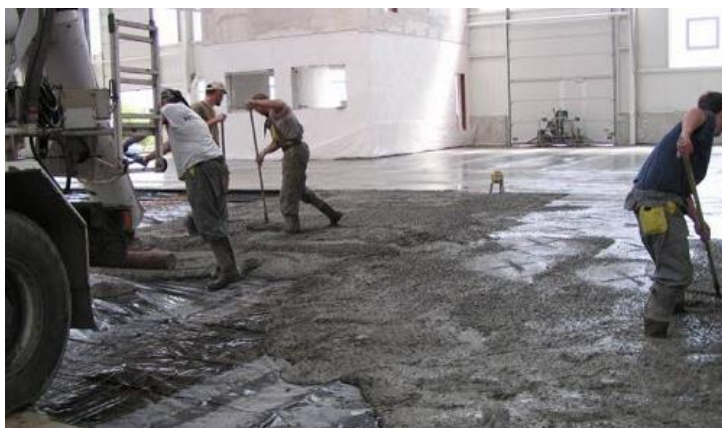
Obrázek 38: Provádění betonové podlahové desky [www.transbeton.cz]
