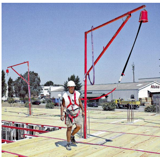
Obrázek 23: Osobní jištění s použitím systému Alsipercha [www.asb-portal.cz]
