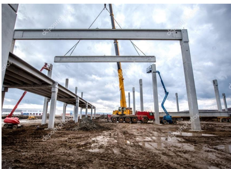
Obrázek 25: Manipulace a montáž prefabrikovaných železobetonových prvků [www.vces-prefa.cz]
