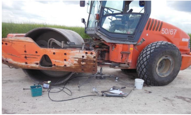
Obrázek 10: Provádění zkoušek únosnosti na zhutněném podloží [archiv autora]
