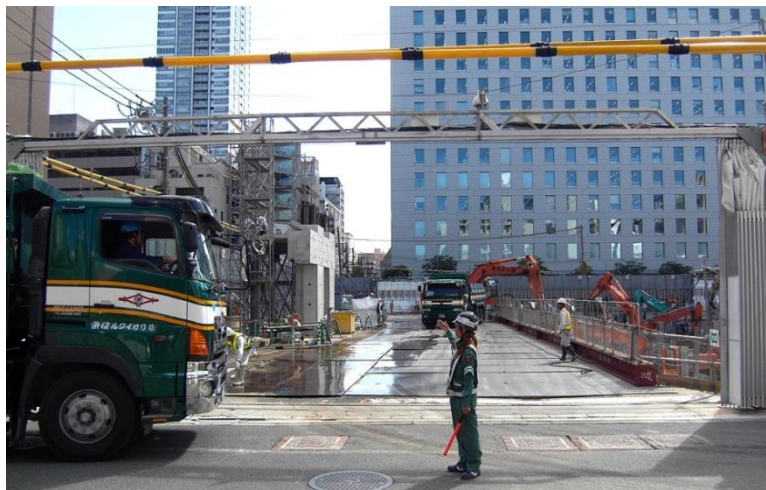
Obrázek 61: Ochrana elektrického vedení a únosná plocha pro dopravu v rámci staveniště [www.cjwalsh.ie]
