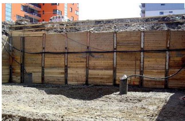
Obrázek 21: Záporové pažení stavební jámy [www.cenekajezek.cz]
