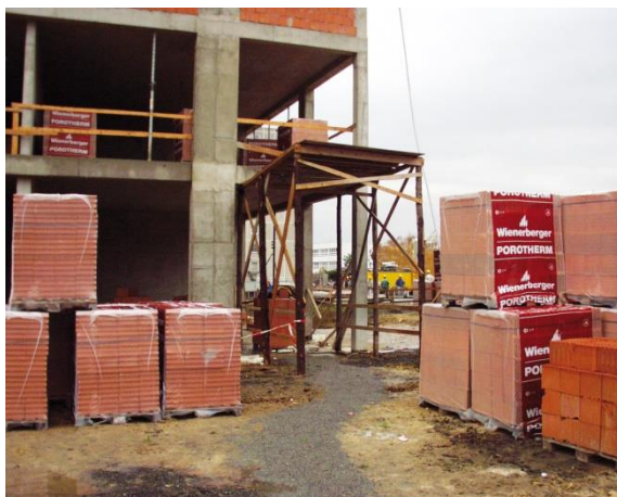
Obrázek 14: Pevné zábrany a ochranná konstrukce proti padajícím předmětům nad vstupem do objektu [www.asb-portal.cz]
