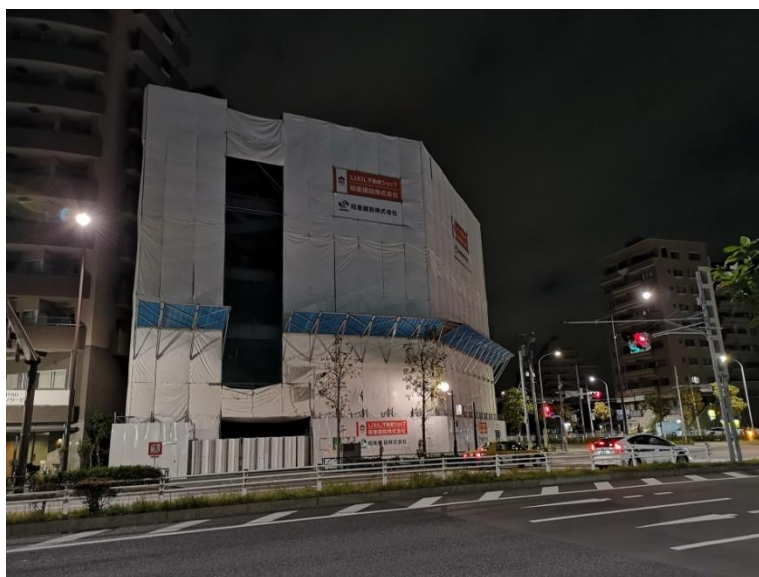
Obrázek 64: Ochrana okolní zástavby proti prachu a šíření požáru [archiv autora]
