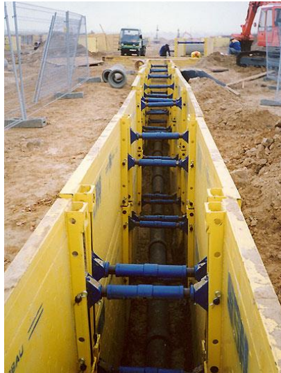
Obrázek 22: Použití pažících boxů [www.testa-jesenice.cz]
