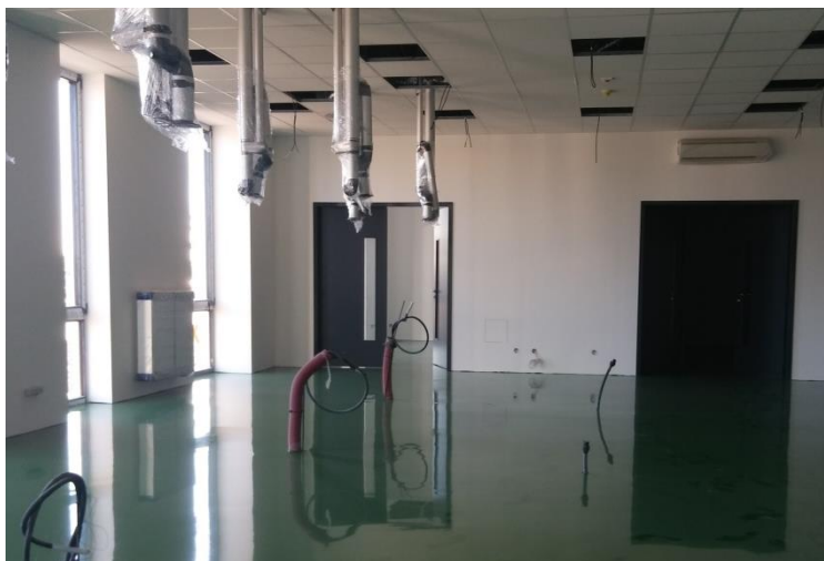
Obrázek 41: Rastrový pohled z minerálních kazet, epoxidová stěrka a malba sádrokartonových příček[archiv autora]
