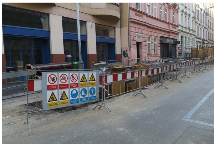
Obrázek 6: Oddělení výkopových prací a veřejné komunikace zábranami [archiv autora]
