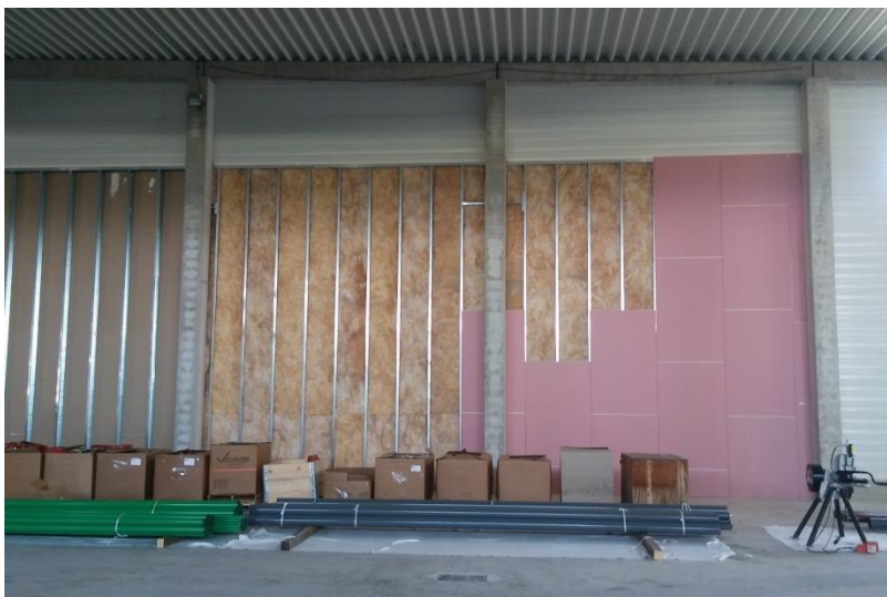
Obrázek 40: Konstrukce sádrokartonových dělicích příček [archiv autora]
