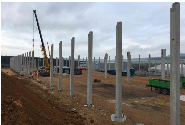
Obrázek 33: Založení prefabrikované konstrukce na pilotových základech [www.ksprefa.cz]
