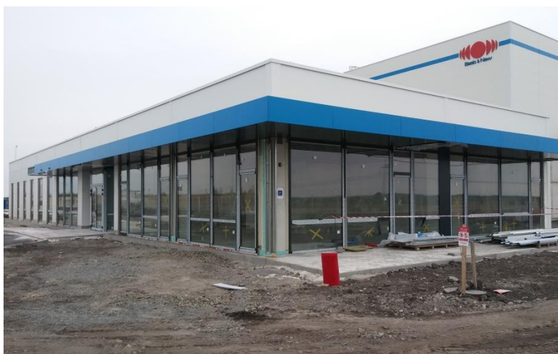
Obrázek 37: Prosklená hliníková stěna administrativní budovy [archiv autora]
