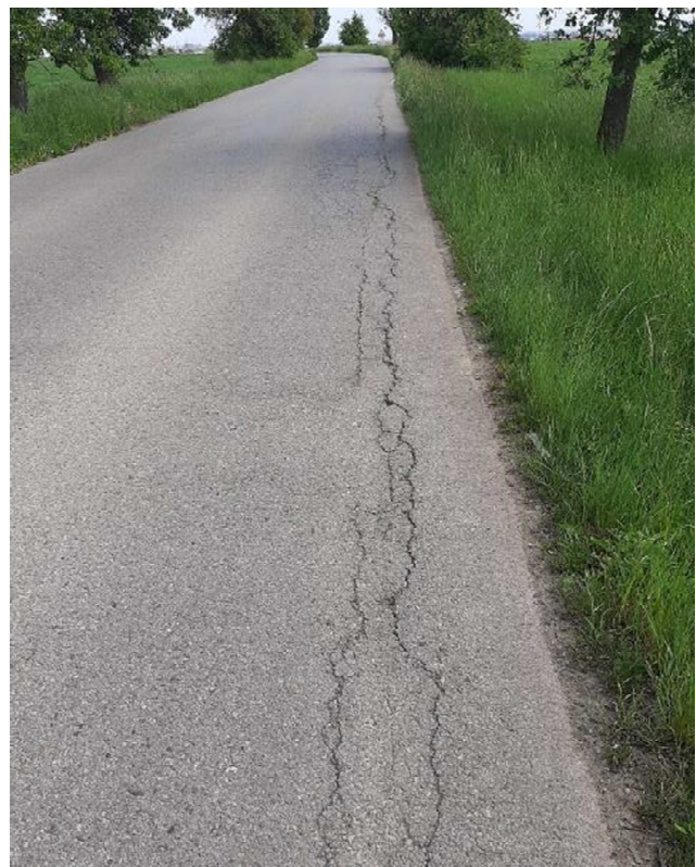
Středočeský kraj, Zbuzany Olamování okrajů/krajnice vozovky
