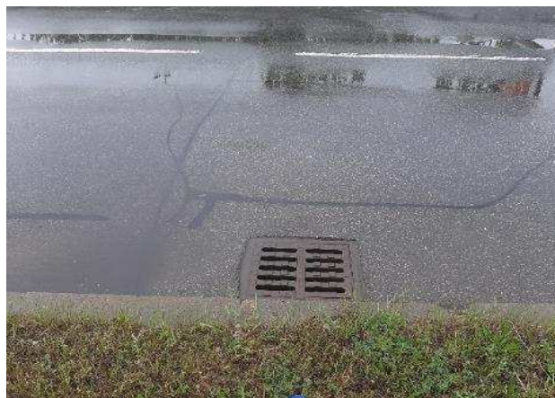
Praha, ul. Bavorského Nefunkční odvodnění, vysoko osazená mříž UV
