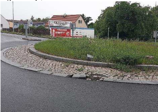
Praha, ul. Na Radosti Výtluk na vnitřním prstenci OK
