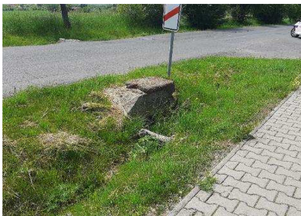
Středočeský kraj, Nučice Nefunkční odvodnění, zhroucený propustek
