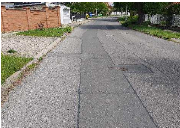
Praha, ul. K Vidouli Propad vozovky po realizaci vodovodního řadu
