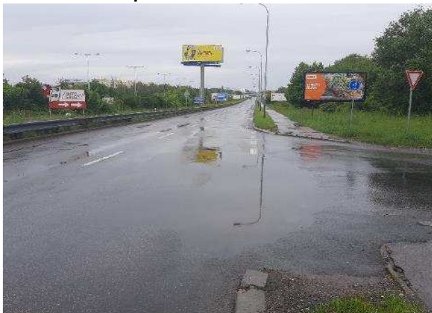
Praha, ul. Bavorského Nefunkční odvodnění, nebezpečí aquaplaningu
