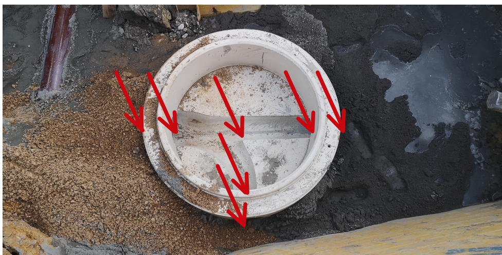
Obrázek 2.3: Měření šachty (pohled shora) [4]
