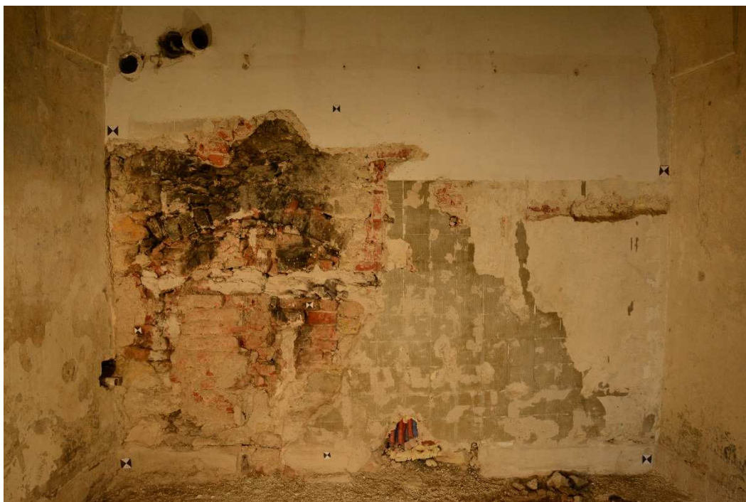
Obr. 11: Černá kuchyně – zadní stěna
