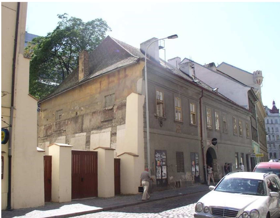
Obr. 1: Dům Truhlářská 1113/8 (Praha 1)
