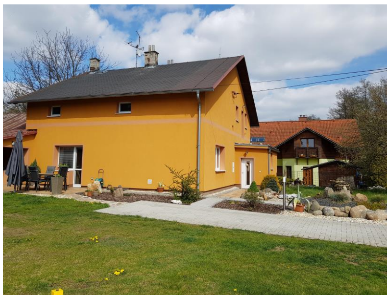
Obr. 3: Pohled na západní část objektu
