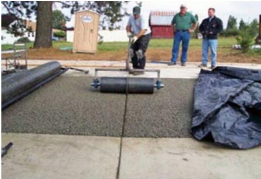
Obrázek 8, Vytváření dilatačních spár. Zdroj: Pervious Pavement
