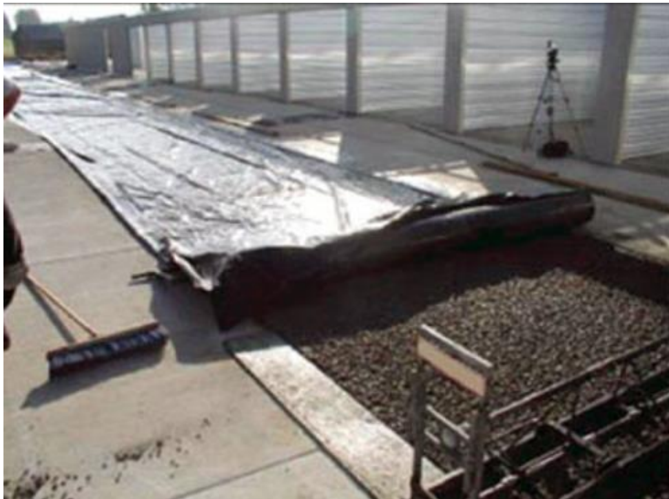
Obrázek 5, Zakrytí fólií kvůli vlhkosti. Zdroj: Pervious Pavement
