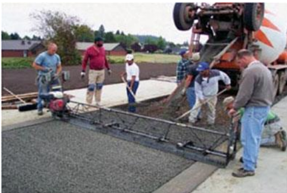
Obrázek 9, Hutnění příložným vibrátorem. Zdroj: Pervious Pavement
