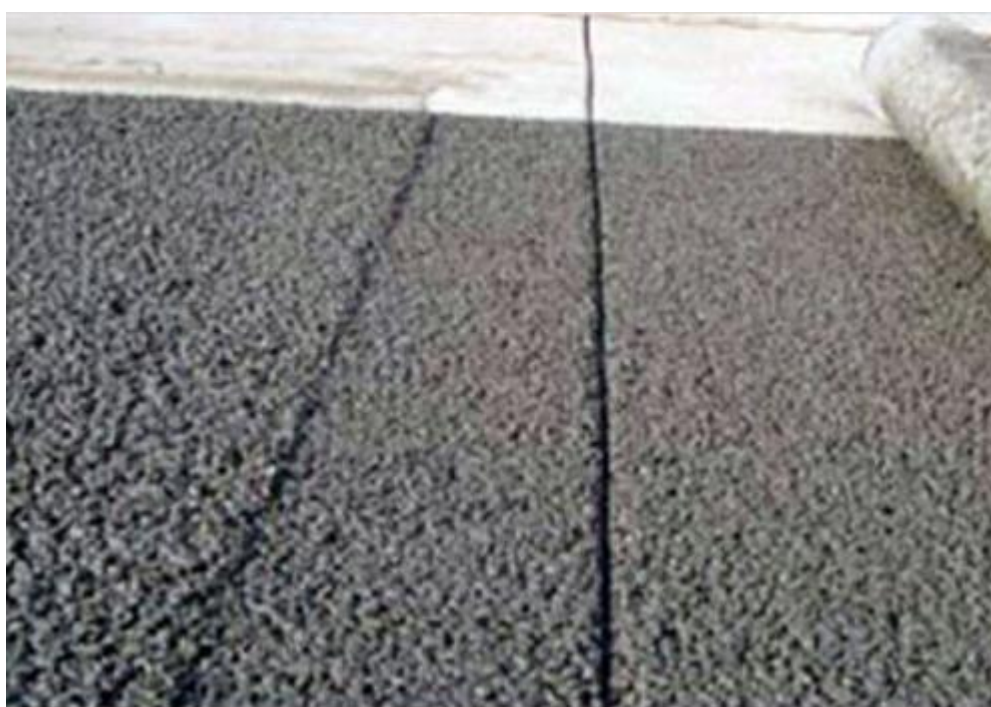
Obrázek 7, Dilatační spára. Zdroj: Pervious Pavement
