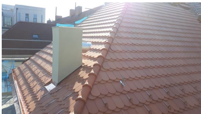
Obr. 61 - vývod vzduchotechniky v komínovém průduchu [41]
