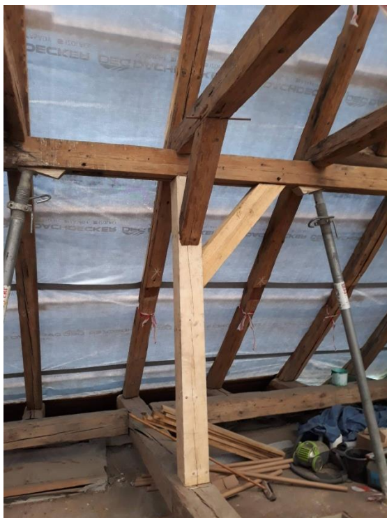
Obr. 47 - výměna sloupku a pásku [40]
