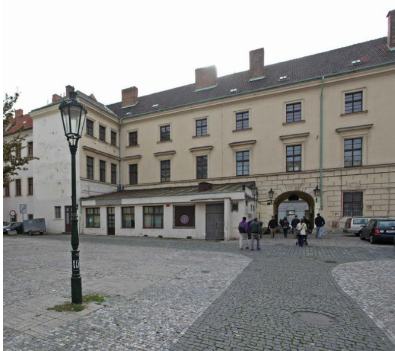
Obr. 27 - původní stav objektu [40]
