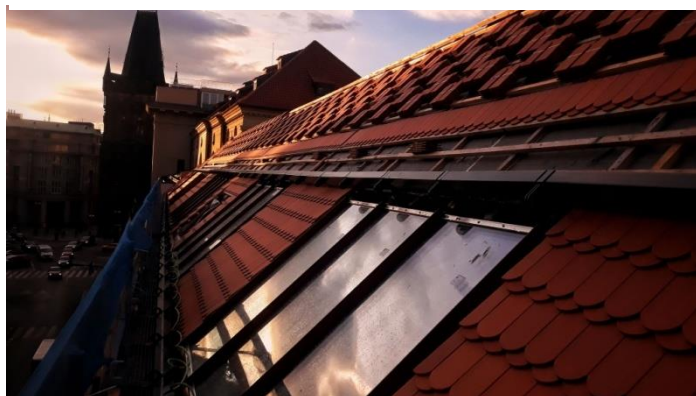
Obr. 59 - jižní strana střechy [41]
