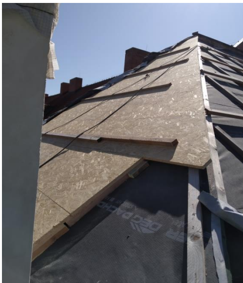
Obr. 56 - pokládání OSB desek [41]
