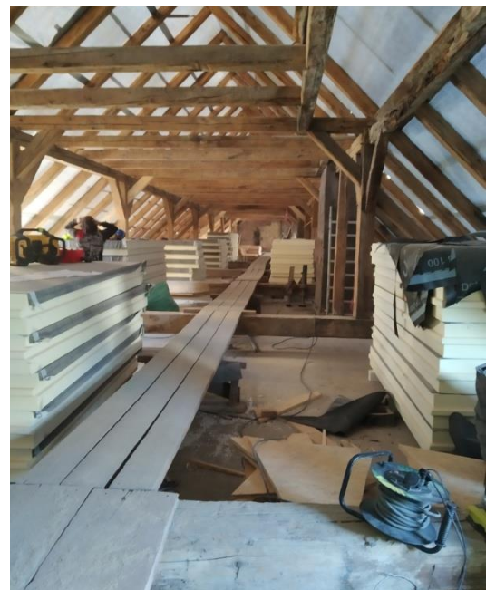
Obr. 55 - skladování PIR desek [41]
