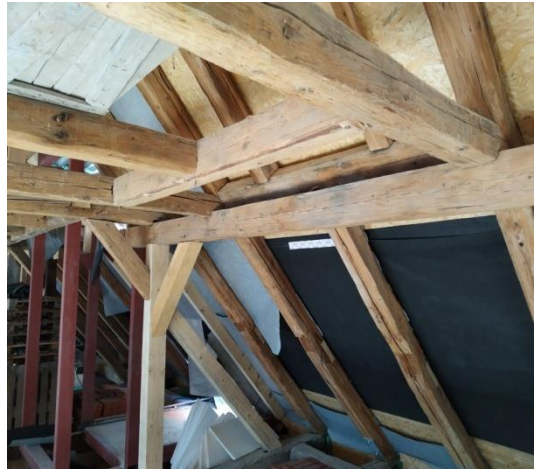
Obr. 53 - vyměněný sloupek [41]
