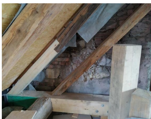
Obr. 49 - protézování krokve [41]
