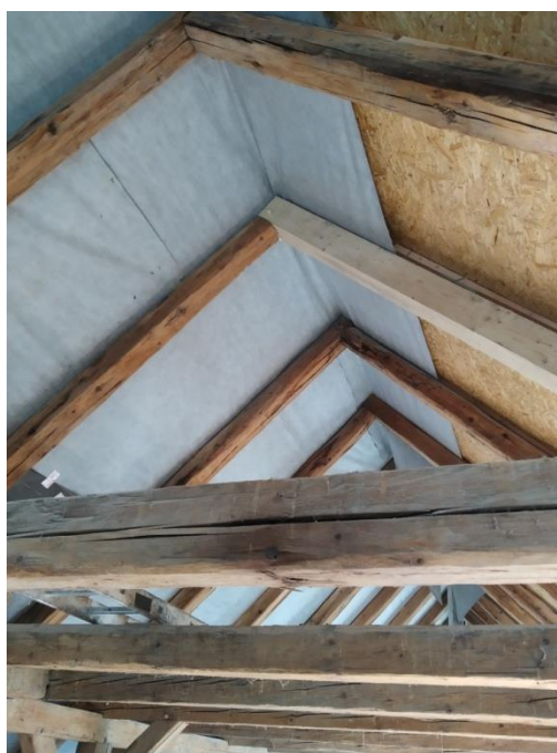
Obr. 51 - výměna celé krokve [41]
