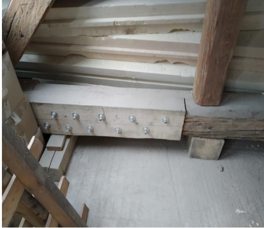
Obr. 52 - protézování vazného trámu [41]
