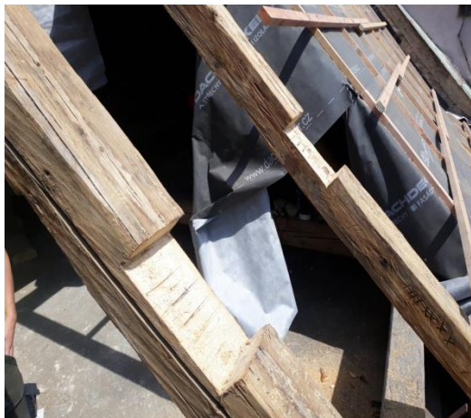
Obr. 43 - příprava plombování [40]
