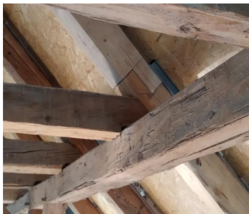
Obr. 48 - protézování krokve nad vaznicí [41]
