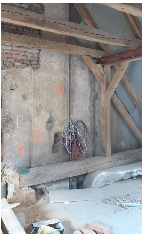
Obr. 50 - vyříznutí vazného trámu z důvodu instalací [40]
