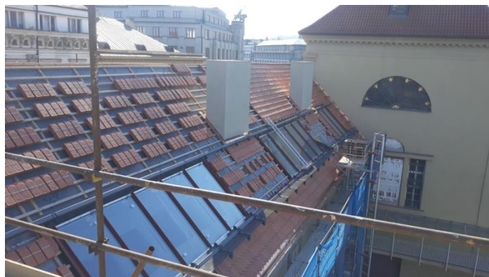
Obr. 58 - střešní okna ve střešním plášti [41]
