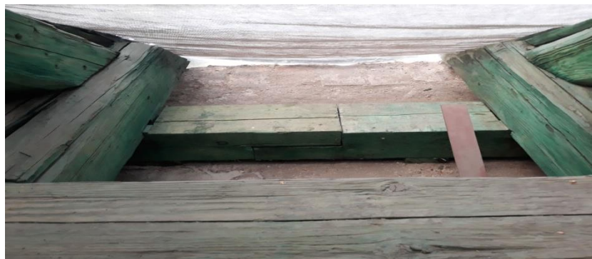
Obr. 46 - impregnace a přelátování pozednice [40]
