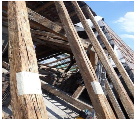
Obr. 44 - plombování krokví [40]
