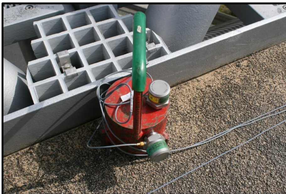
Obr. 18 Dva snímače zrychlení 8344 připevněné magnetem k ocelovému závaží
