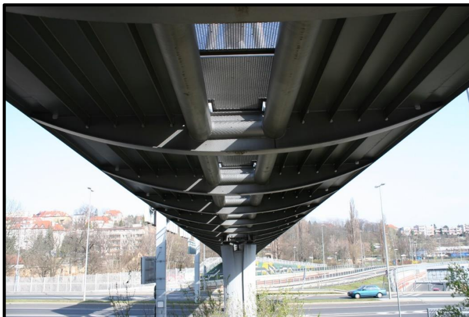
Obr. 16 Pohled na nosnou konstrukci lávky zdola
