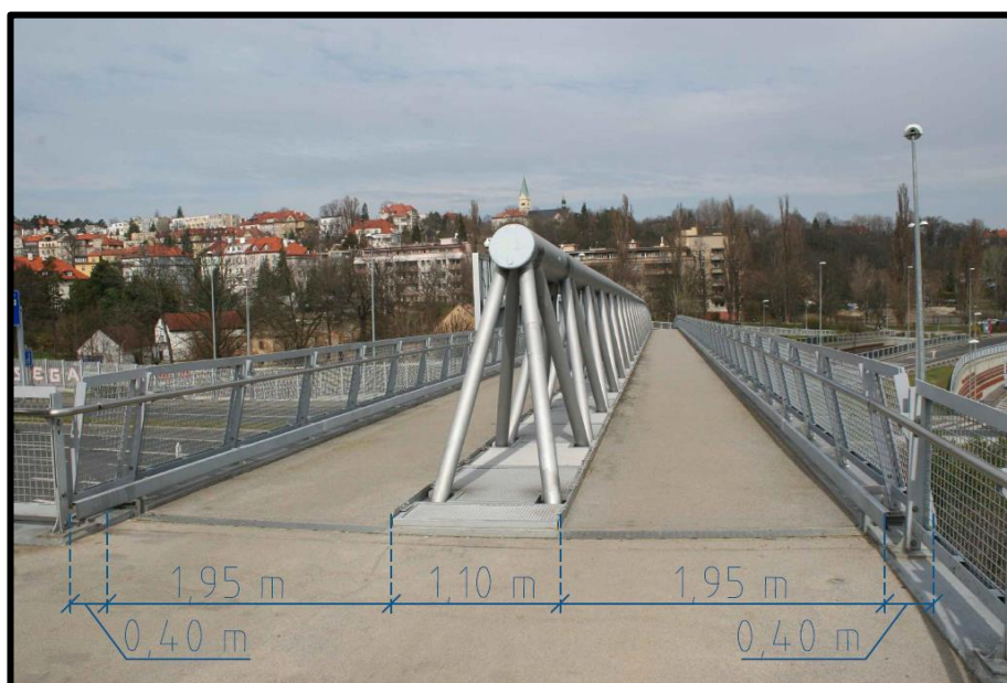
Obr. 13 Pohled na příčný řez lávky včetně rozměrů
