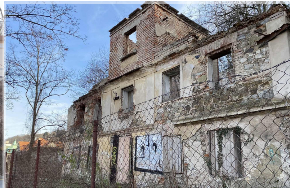
Obr.3 - pozůstatky bývalého objektu
