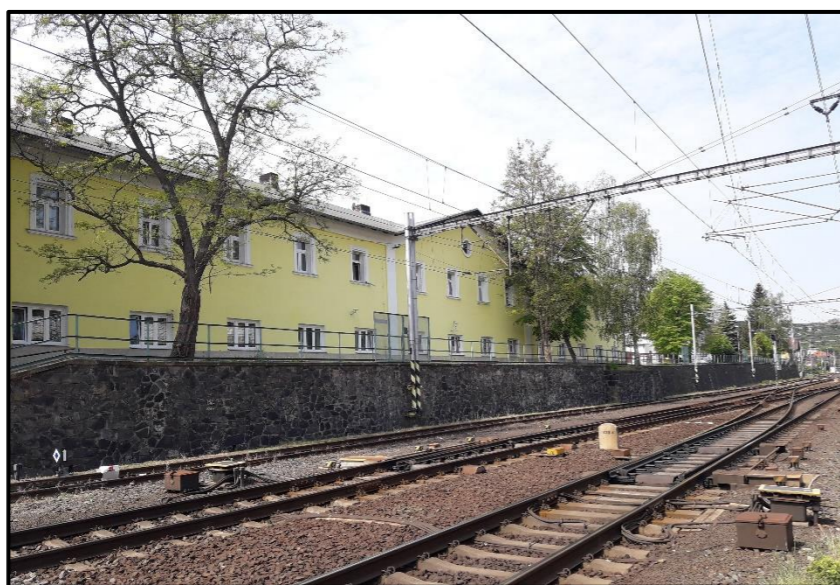
Obr. 38: Absence protihlukových stěn u železniční trati v blízkosti zástavby
