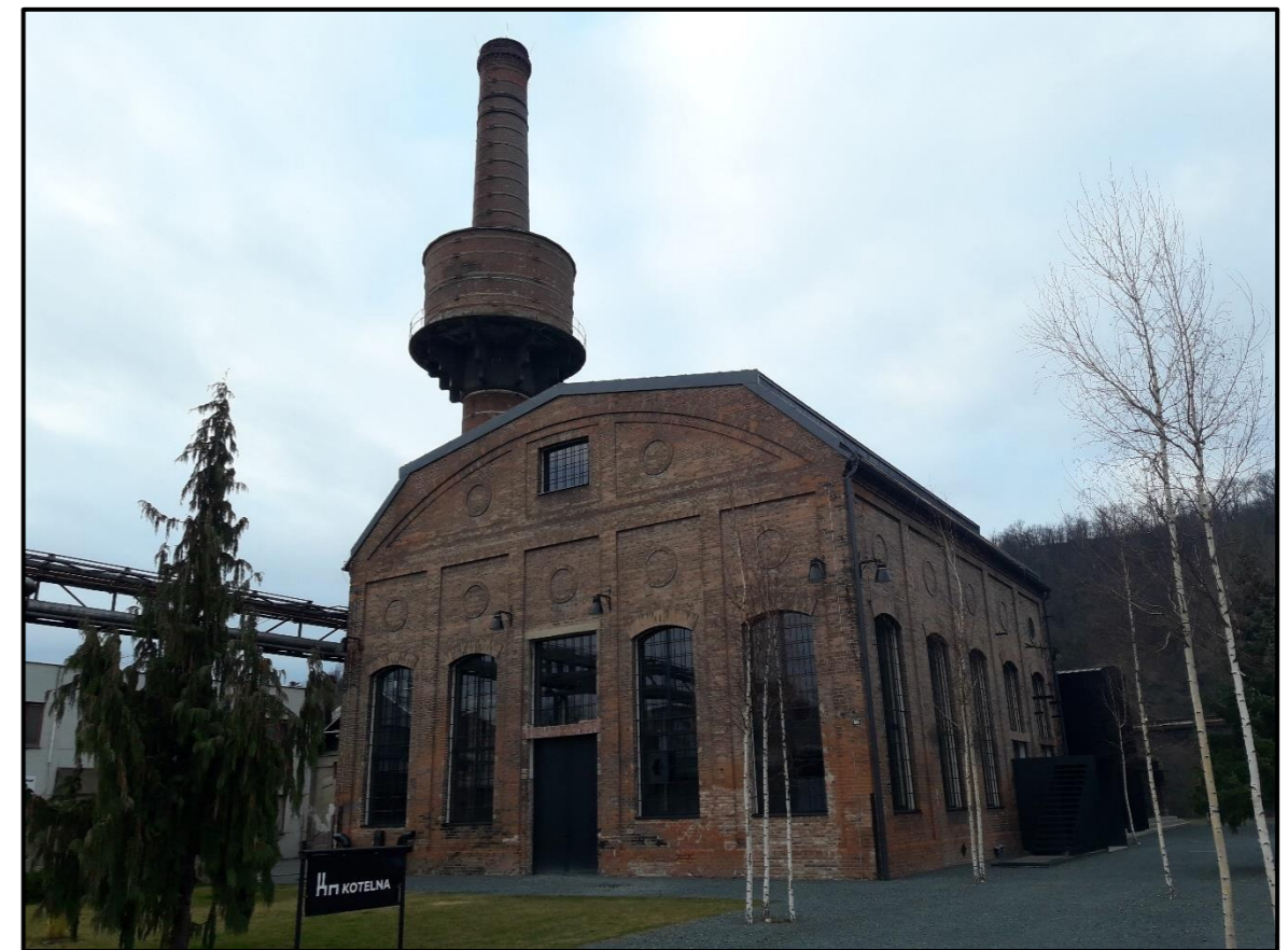
Obr. 13: Uhelný mlýn, Kotelna v Libčicích nad Vltavou
