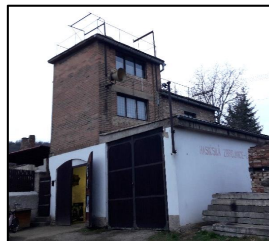
Obr. 30: Hasičská zbrojnice Libčice nad Vltavou
