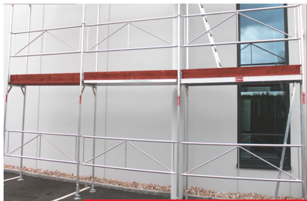
Obr. 30 - Foto fasádního lešení RINGER [11]
