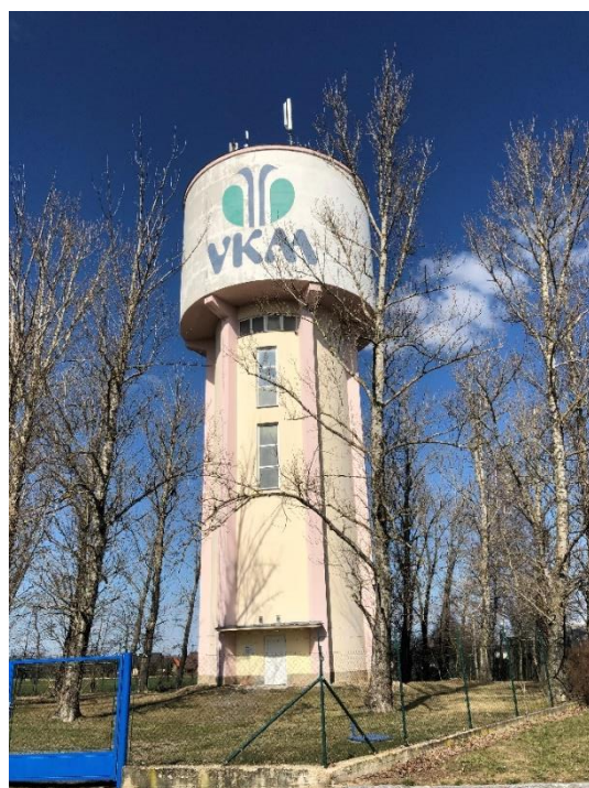
Obrázek 28 – věžový vodojem Stochov
