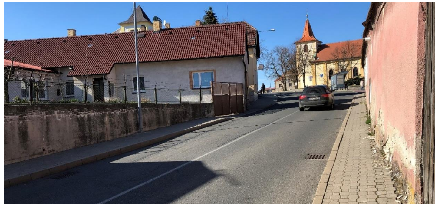
Obrázek 31 – nedostatečně široký chodník v ulici Osvobození
