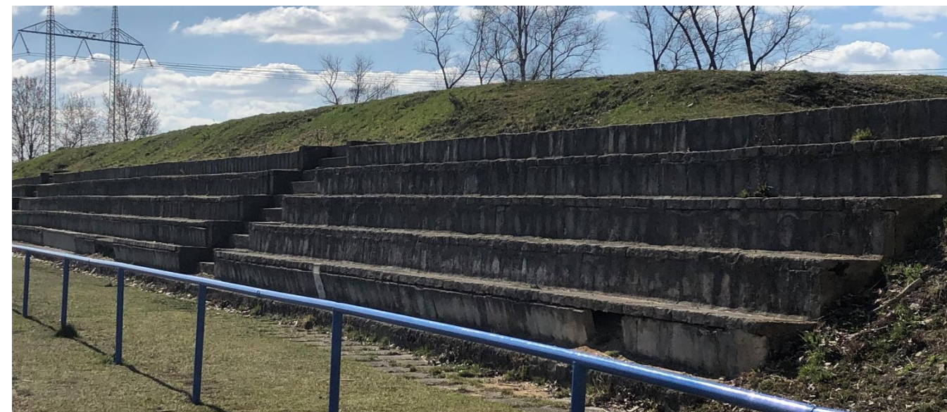
Obrázek 43 – nerekonstruované fotbalové tribuny
