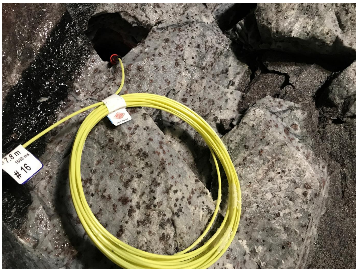
Obrázek 35 Detail vrtu s připravenou neelektrickou rozbuškou a počínovou náložkou [28]
