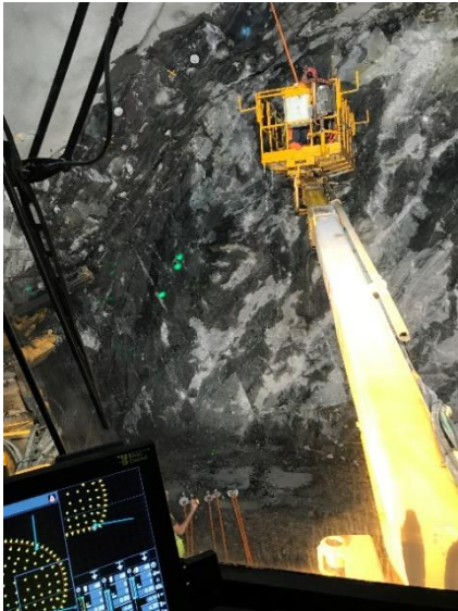
Obrázek 36 Osazování svorníků [28] Obrázek 37 Začištění výrubu tlakovou vodou [28]
