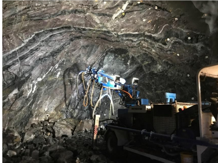
Obrázek 36 Osazování svorníků [28] Obrázek 37 Začištění výrubu tlakovou vodou [28]
