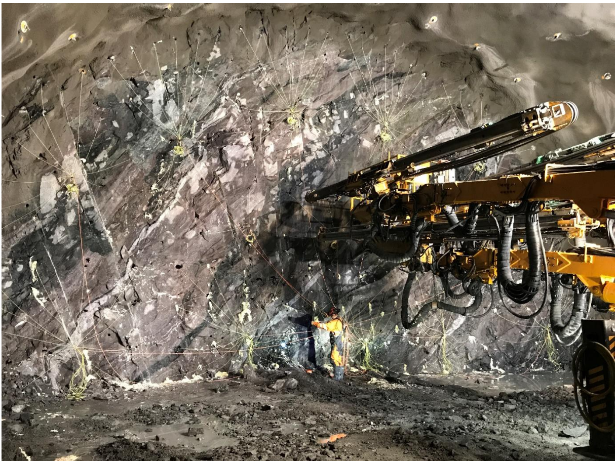
Obrázek 39 Čelba chvíli před odpalem [28]
