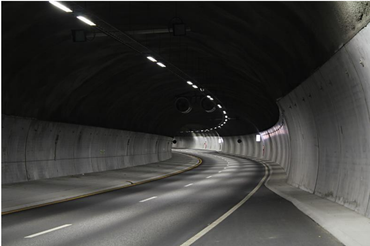
Obrázek 9 Sekundární ostění hotového tunelu raženého NTM [27]
