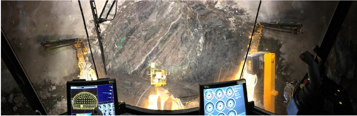
Obrázek 38 Pohled z vrtné soupravy na čelbu [28]
