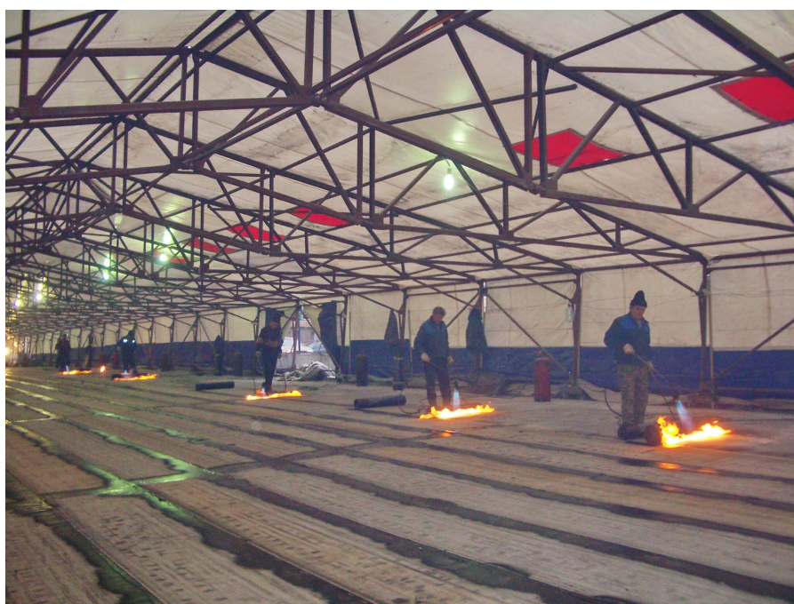
Obr. 10: Provedení hydroizolace ve vytápěném stanu, zdroj: [22]
