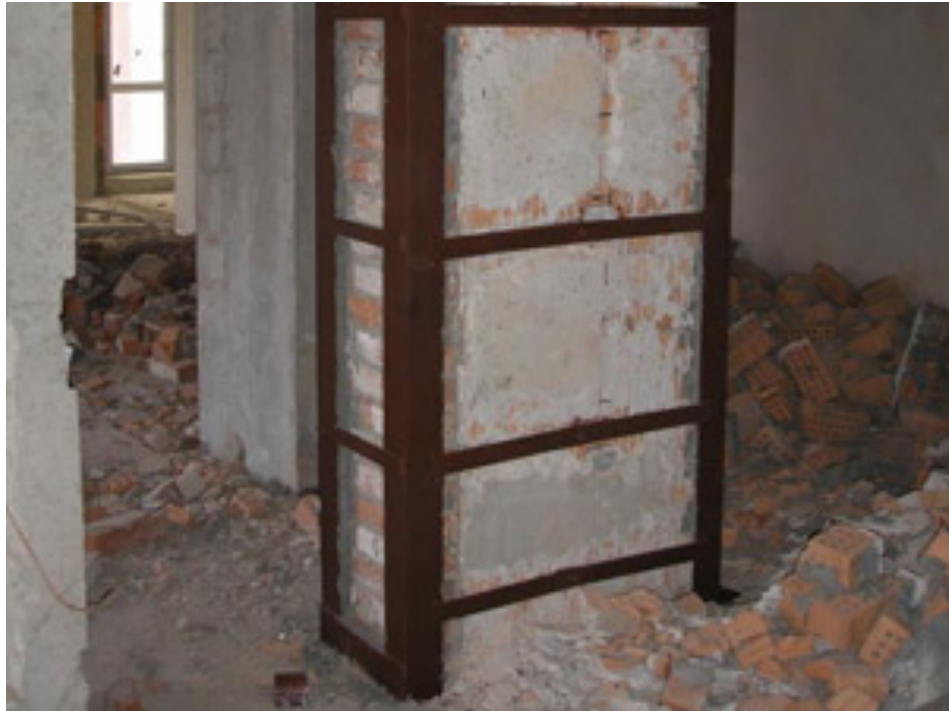
Obr. 9: Zesílení sloupu, zdroj: [21]
