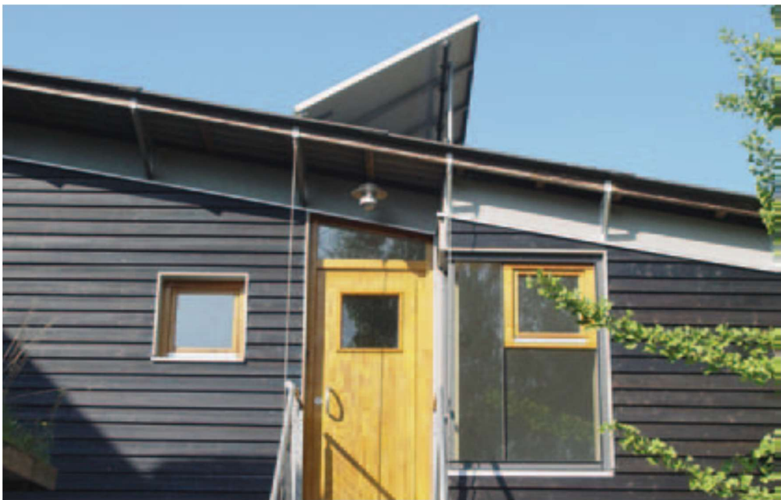
Obrázek 29 - Tmavá fasáda s vysokou tepelnou akumulací
