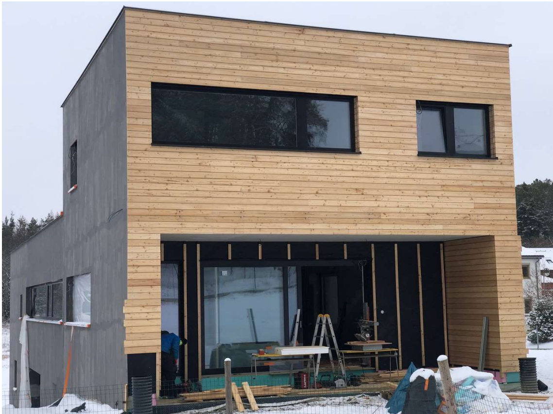
Obrázek 59 Realizace fasády ze Sibiřského modřínu
