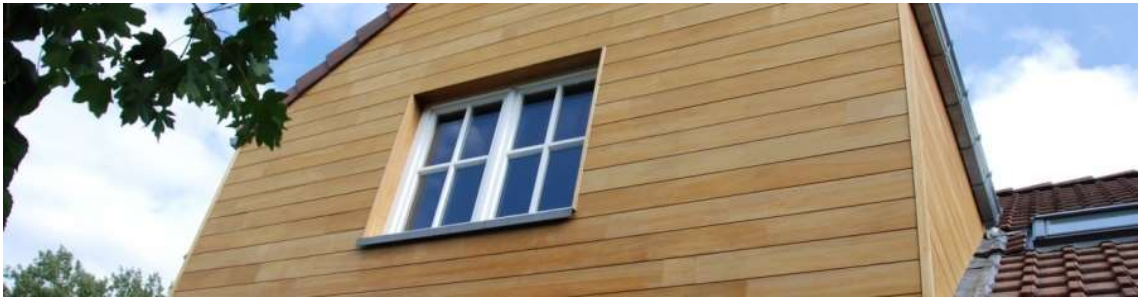
Obrázek 12 - Fasáda systému techniclic bez viditelného upevnění
