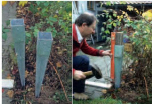
Obrázek 45 Zatloukácí a šroubovací kotvy
