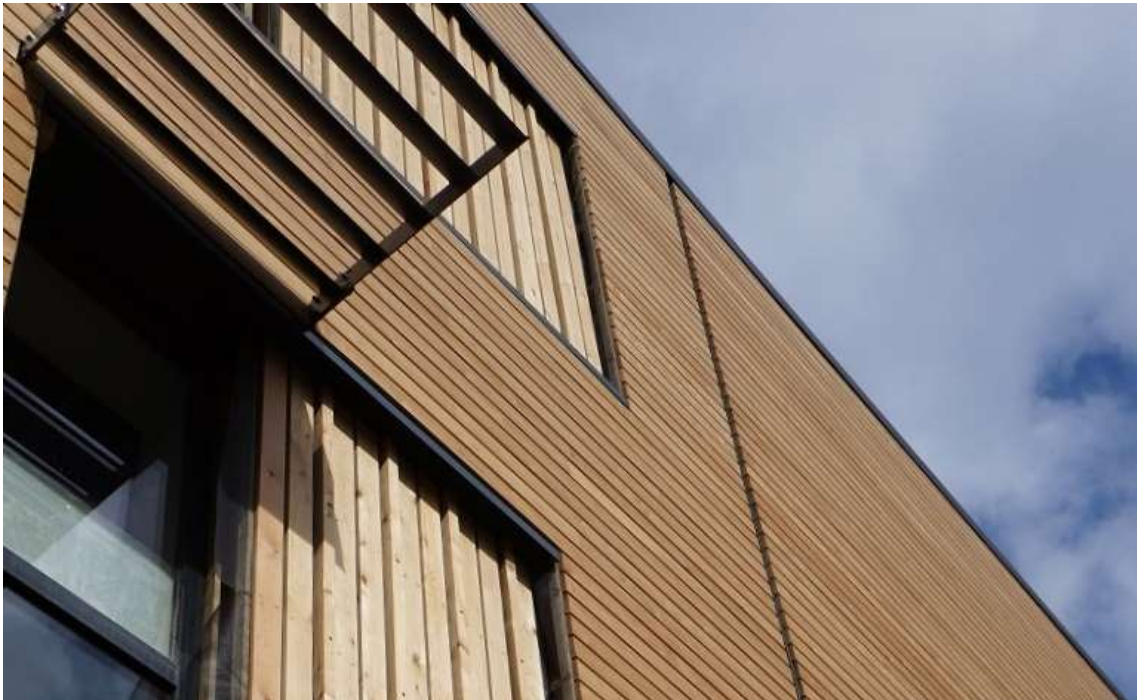
Obrázek 38 - Fasáda ze dřeva Thermowood
