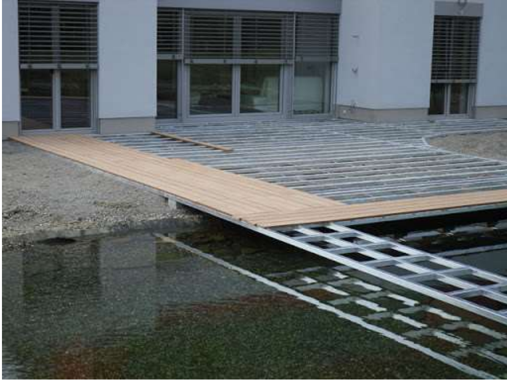
Obrázek 49 Ocelová podkladní konstrukce
