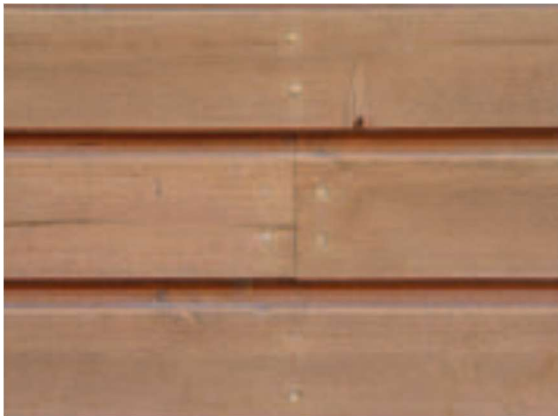
Obrázek 8 - Viditelné upevnění vodorovné
