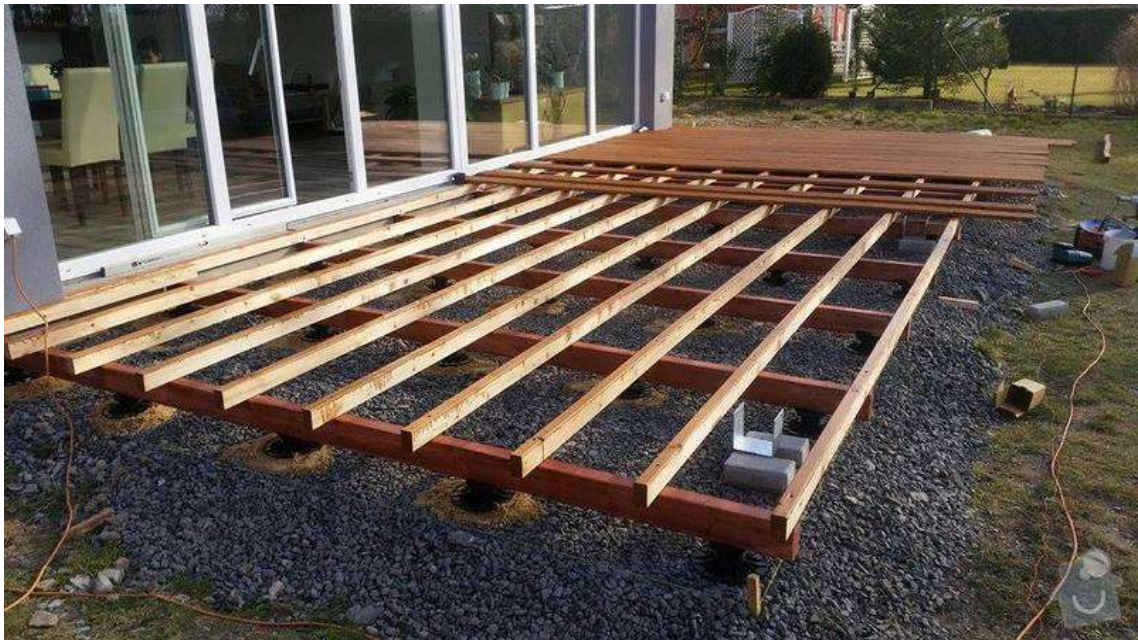
Obrázek 48 Podkladní konstrukce terasy
