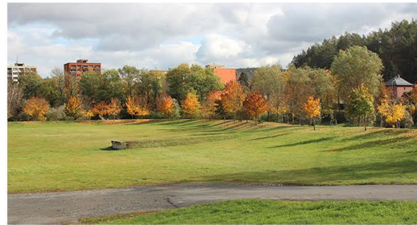
Podzámčí _ protipovodňový val _ 2
