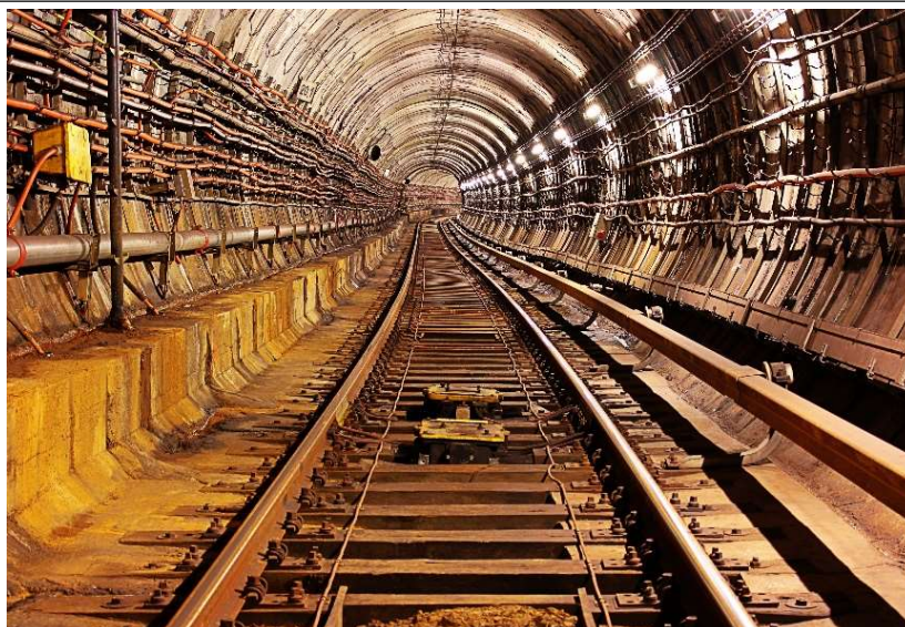
Obr. 4: Tunel metra ve sledované oblasti (vlastní zdroj)
