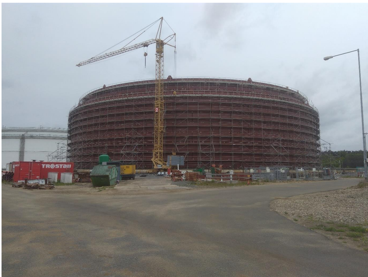
Obr. 6: Nádrž H13 při výstavbě (zdroj: Ing. Jaroslav Braun Ph.D.)
