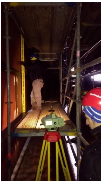
Obr. 15: Měření v prostoru jímky (zdroj: Ing. Jan Kadlec)
