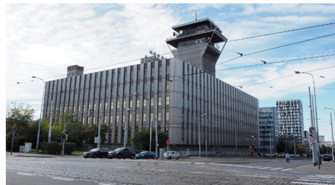
Budova CETIN určená k demolici
