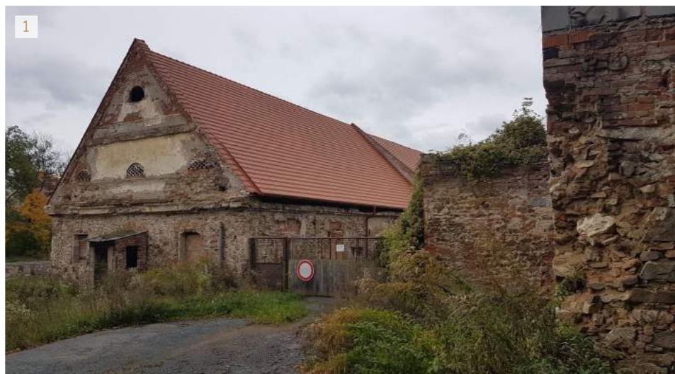
1 HOSPODÁŘSKÉ BUDOVY Historický hospodářský dvůr byl v havarijním stavu. V roce 2017 bylo na objektech provedeno statické zajištění historických krovů a pokládka nové krytiny.
