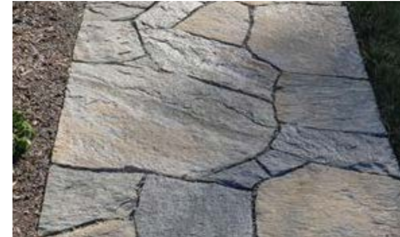
D6 - kamená dlažba - nepravidelné kusy
