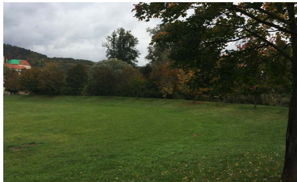
pohled na protipovodňový val
