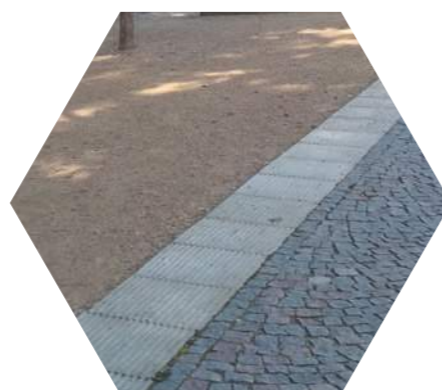
detail přechodu materiálů: betonový „pás“
