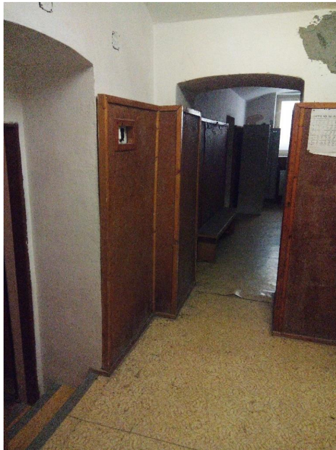
Fotografie 1 chodba suterén zdroj – vlastní
