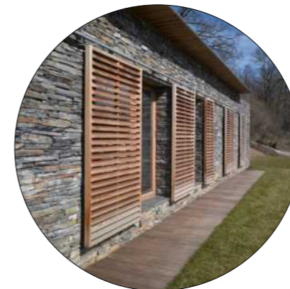
1 JIŽNÍ A ZÁPADNÍ OKNA
