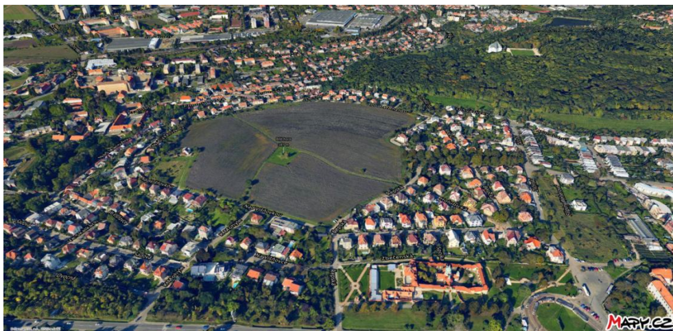
Obr. 2 Oblast Bílé Hory (v pravém dolním rohu pohled na stávající obratiště) [5]
